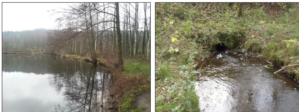
Obrázek č. 20, 21 – vlevo koruna hráze Ostrovského rybníka s neuzpevněnou komunikací; vpravo spodní zatrubněná výpust v patě hráze Ostrovského rybníka (zdroj: vlastní)
