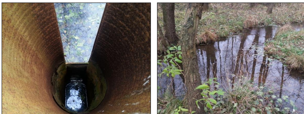
Obrázek č. 24, 25 – na levém obrázku ocelový požerák retenční nádrže; vpravo soutok odtoku Ostrovského rybníka a retenční nádrže v lužním lese (zdroj: vlastní)
