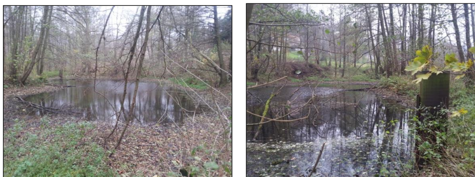
Obrázek č. 22, 23 - pohled na retenční nádrž z hráze Ostrovského rybníka; pohled od požeráku retenční nádrže směrem ke hrázi Ostrovského rybníka (zdroj: vlastní)
