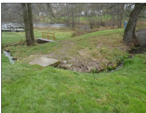
Obrázek č. 15 - nehrazený přeliv rybníku u hotelu Ostrov, sloužící jako bezpečnostní přeliv, začleněný do terénních úprav (zdroj: vlastní)
