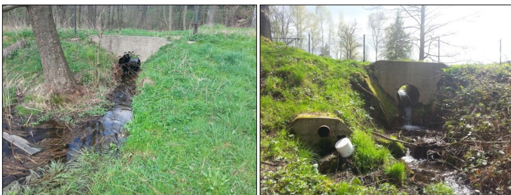
Obrázek č. 16, 17 - bezpečnostní přeliv Ostrovského rybníka z návodní strany hráze; vpravo bezpečnostní přeliv Ostrovského rybníka ze vzdušné strany hráze (zdroj: vlastní)
