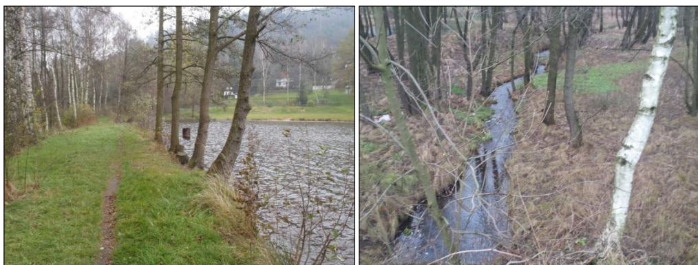
Obrázek č. 18, 19 - pohled z koruny hráze na požerák Ostrovského rybníka; pohled z koruny hráze na odtok z požeráku do lužního lesa pod hrází (zdroj: vlastní)
