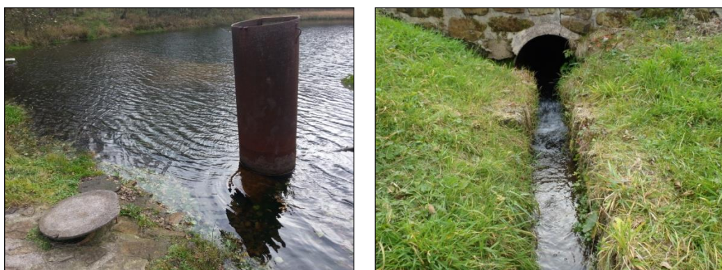
Obrázek č. 11, 12 - požerák rybochovného rybníku z ocelové trubky se zakrytým bezpečnostním přelivem v opevněném návodním svahu, na pravém obrázku spodní potrubí výpusti rybochovného rybníka a zároveň přítok rybníku u hotelu Ostrov (zdroj: vlastní)
