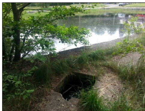
Obrázek č. 8, 9 – Vlevo koupaliště v havarijním stavu, vpravo šachta bezpečnostního přelivu koupaliště (zdroj: vlastní)
