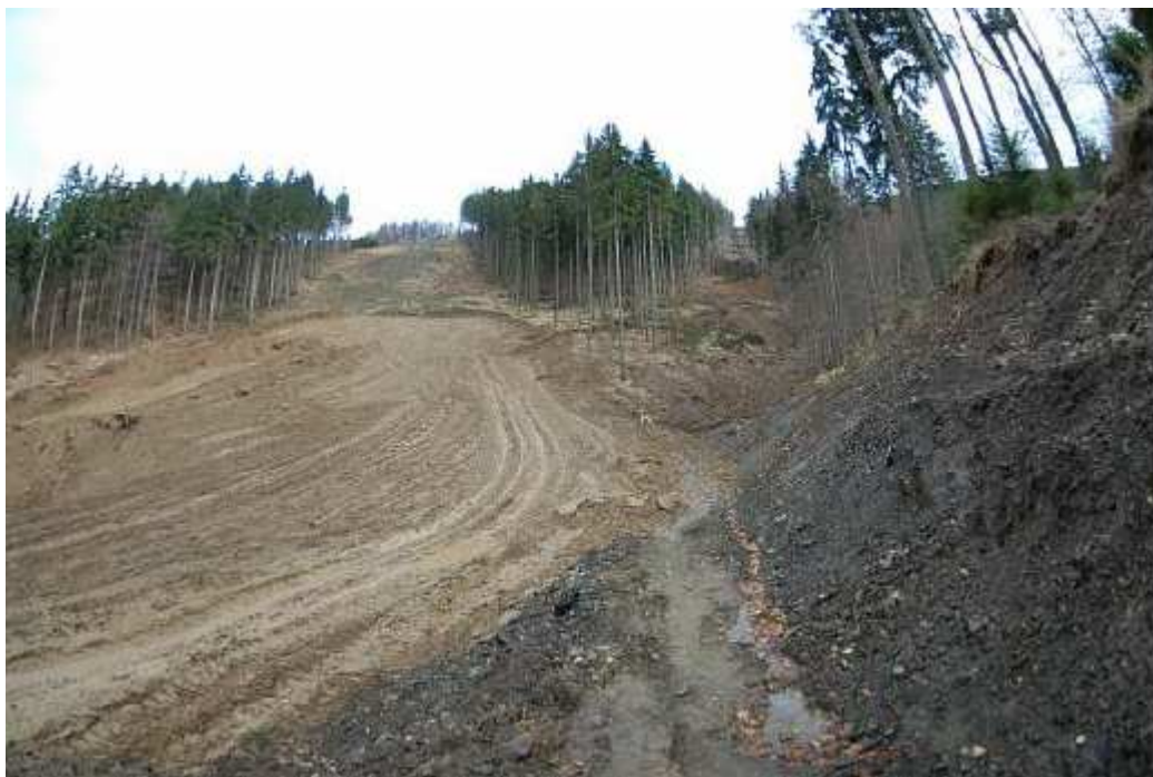
Obr. 8.1.3: Zahájení výstavby areálu (Zdroj: http://sumpersky.denik.cz )
