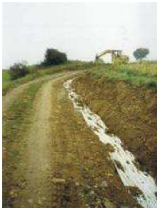
Obr. 8.3.1: Odvodňovací drén (Zdroj: http://geologie.vsb.cz )
