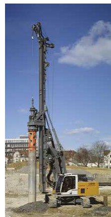
Obr. 2.2.1 Vrtná souprava Liebherr LB 16
