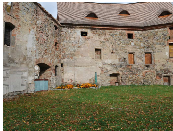
Obr 112. - Pohled na severní část nádvoří (autor 2023)
