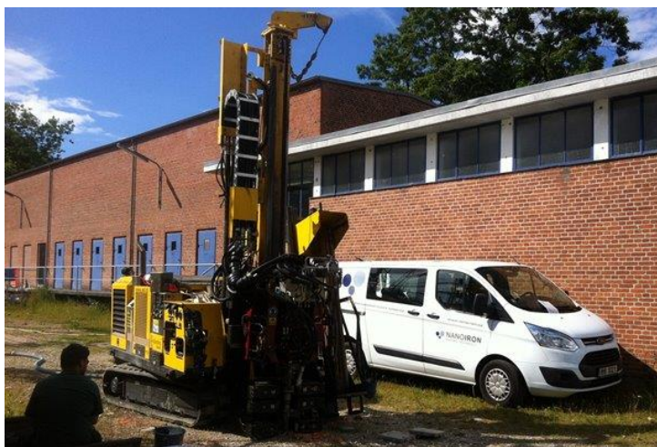
Obr. 6: Sanace podzemní vody. [21]
