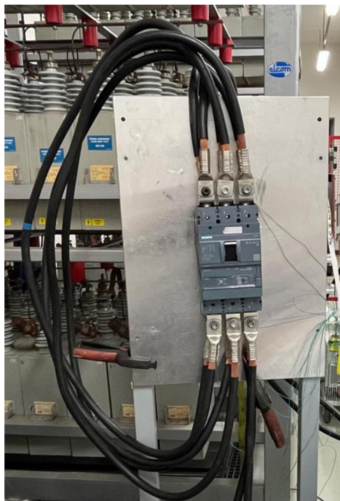
Obrázek 3.7 Úprava zapojení smyčka (630 A, AC)
