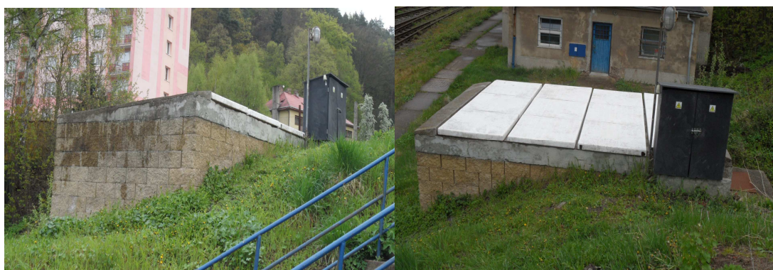
Foto č. 9: Mechanicko-biologická čistírna odpadních vod obestavěná tvarovkami KB-BLOK – čistírna Děčín-Loubí (foto 2014).
