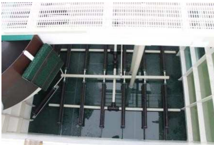
Foto č. 11: Aktivační zóna s nitrifikačním procesem – čistírna „EK-S 150 EO“ od firmy EKOCIS s. r. o. ( www.ekocis.cz ) (cit. 2014. 02. 20).
