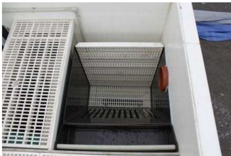
Foto č. 8: Česlicový koš a současně denitrifikační zóna – umístěný přímo v biologickém reaktoru v nátokové zóně – čistírna „EK-S 150 EO“ od firmy EKOCIS s. r. o. ( www.ekocis.cz ) (cit. 2014. 02. 20).
