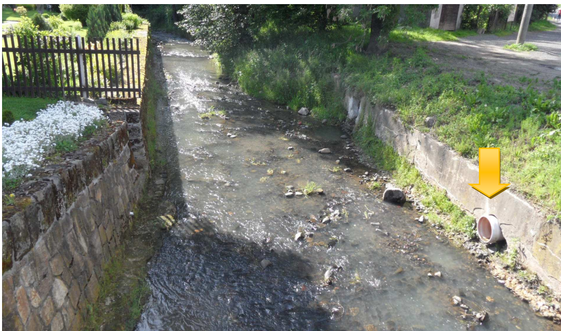
Foto č. 5: Konečný recipient, potok Bystrá – vpravo dole (žlutá šipka) je k vidění vyústění místního příkopu se znečištěnou vodou (foto 2014).
