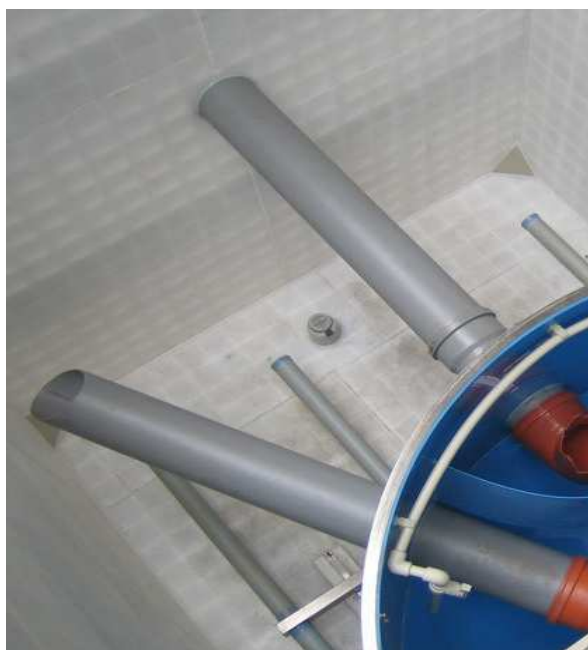
Foto č. 10: Aktivační zóna s nitrifikačním procesem – čistírna „BioCleaner BC 150“ od firmy ENVI-PUR s. r. o. ( www.envi-pur.cz ) (cit. 2014. 02. 20).
