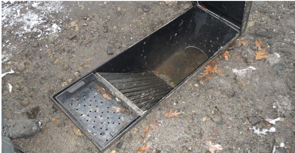
Foto č. 6: Česle – umístěné před samotnou čistírnou odpadních vod v Markvarticích (foto 2013).
