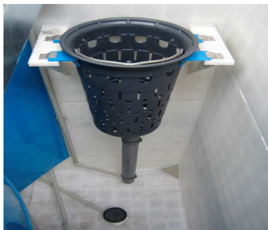
Foto č. 7: Česlicový koš a současně denitrifikační zóna – umístěný přímo v biologickém reaktoru v nátokové zóně - čistírna „BioCleaner BC 150“ od firmy ENVI-PUR s. r. o. ( www.envi-pur.cz ) (cit. 2014. 02. 20).
