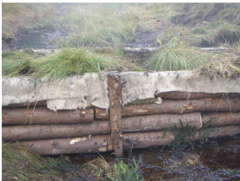
(Obr. č. 22., Revitalizační přehrážka typu C v konečném stavu, autor: Bc. Kamila Krosová)
