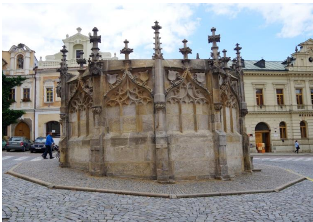
Obr. č. 25: Kamenná kašna (foto autor)
