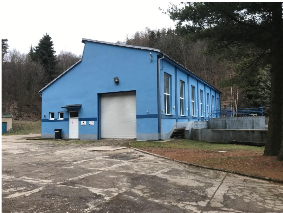
Příloha 1: Technická budova MVE Meziboří, (zdroj: autor).
