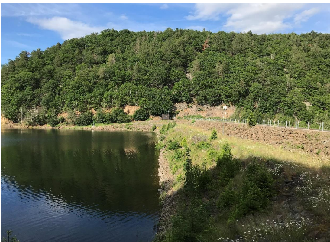
Příloha 10: Zemní hráz VD Jirkov, (zdroj: autor).
