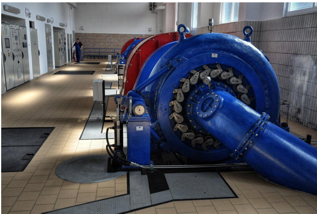
Obr. 16: Vnitřní prostory MVE Meziboří a Francisovi turbíny, (zdroj: Schola Humanitas).
