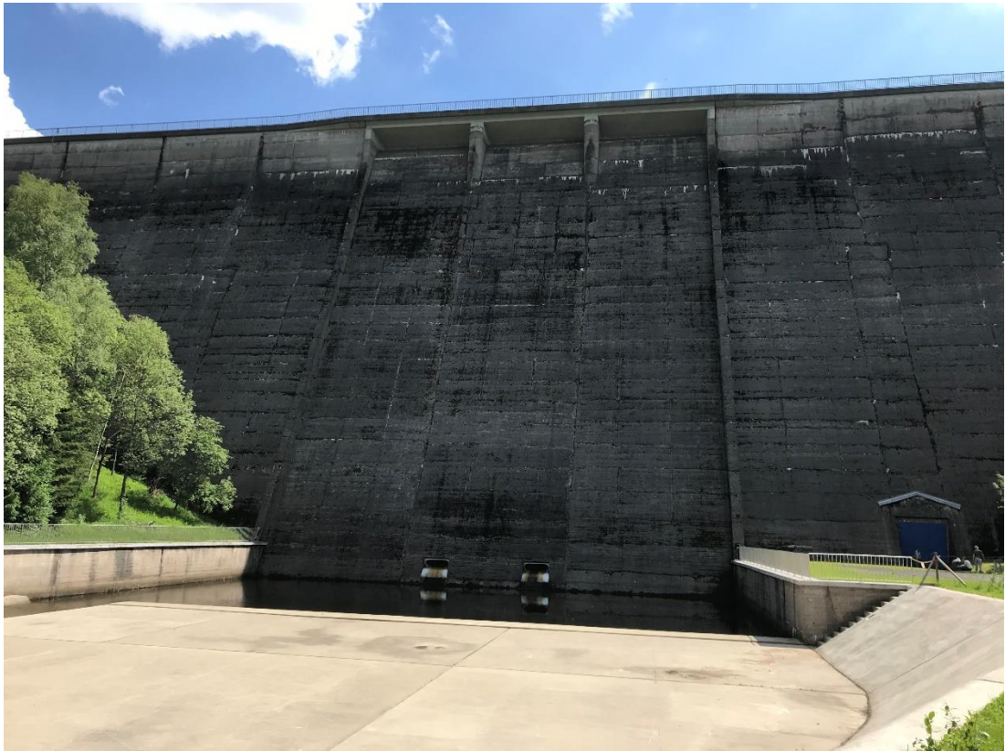
Příloha 3: Hráz VD Fláje, (zdroj: autor).
