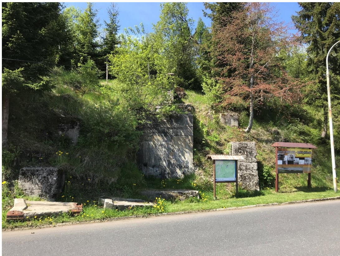
Příloha 11: Pozůstatky základů stanice nákladní lanovky na Moldavě v Krušných horách, (zdroj: autor).
