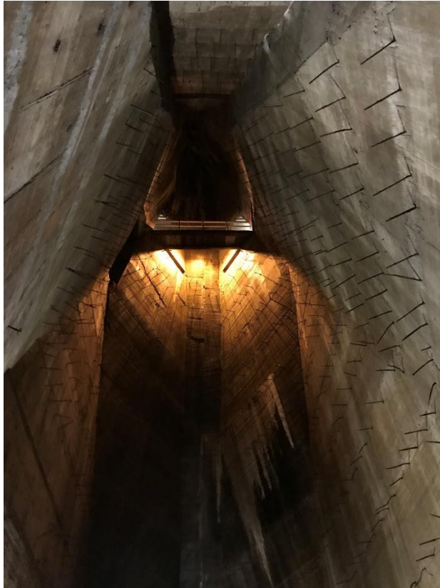
Příloha 17: Pohled vzhůru na vnitřní prostor dutého pilíře typu Noetzli, (zdroj: autor).
