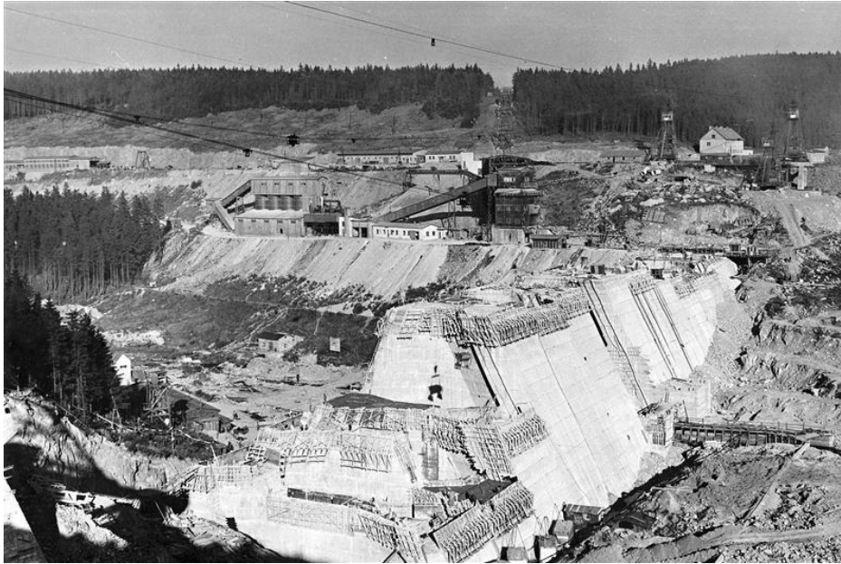
Obr. 9: Stavba hráze, (zdroj: http://www.poh.cz/historie-vystavby-vd/gs-1036 ).
