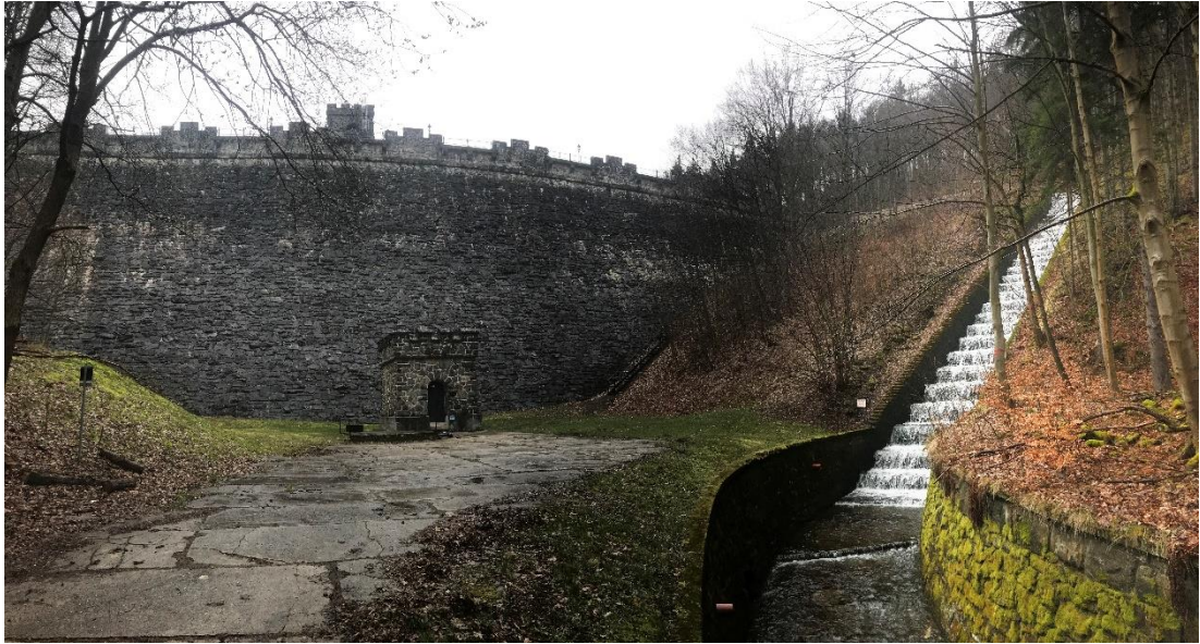
Příloha 5: VD Kamenička s kaskádou bezpečnostního přelivu, (zdroj: autor).
