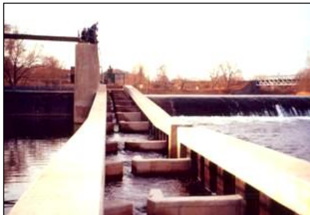
Obr. č. 5 Štěrbínový přechod (Zdroj, P. Dvořák)
