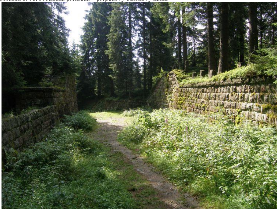
Obrázek č. 18: Protržená přehrada – přepadový odtokový kanál
