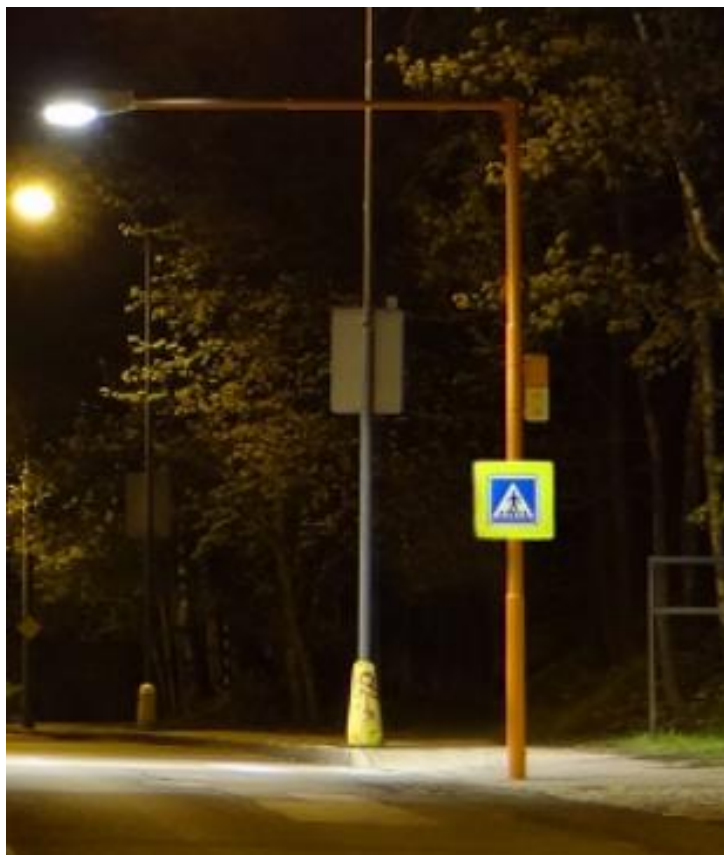
Obr. 8 Příklad osvětlované SDZ, Zdroj [Autor]
