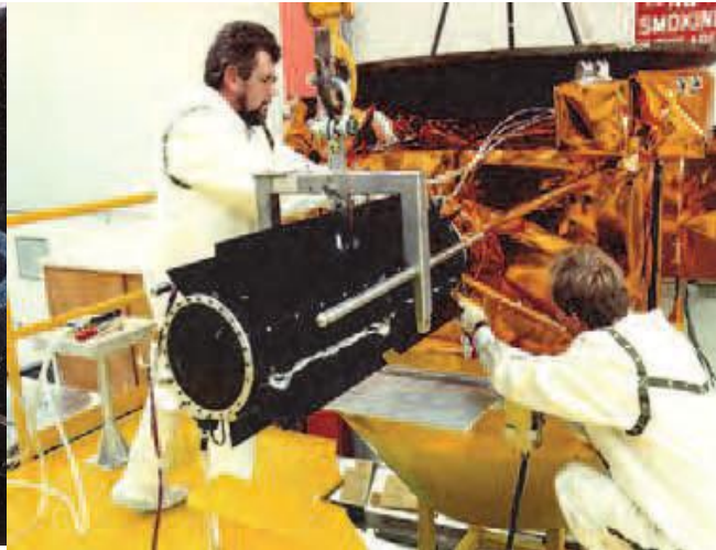
Obr. 7 Inštalácia RTG systému na sondu Ulysses [9]
