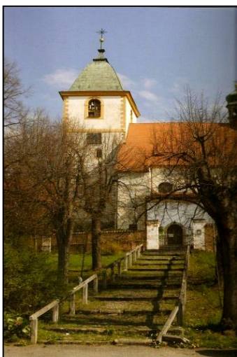
Obr. 44: Kostel Panny Marie, dnes gotická jednolodní stavba s mohutnou věží, stav listopad 2010 Zdroj: Magda Chodorová
