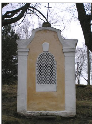
Obr. 110: Výklenková kaplička, ul. Třebenická, stav leden 2012 Zdroj: Magda Chodorová
