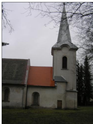
Obr. 125: Kostel Povýšení sv. Kříže, hřbitovní, původně gotický, stav leden 2012 Zdroj: Magda Chodorová
