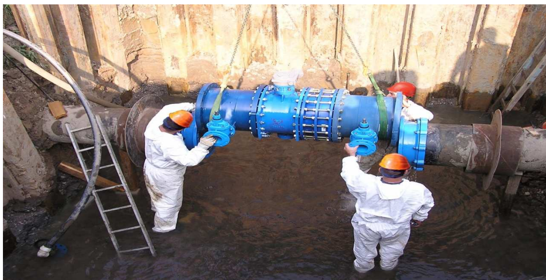
Obr. 21 - osazení výřezu - 2x chránička, 2x příruba UNIEXTRA, 2x t-kus, 1x uzavírací klapka VOD-KA a 1x montážní vložka
