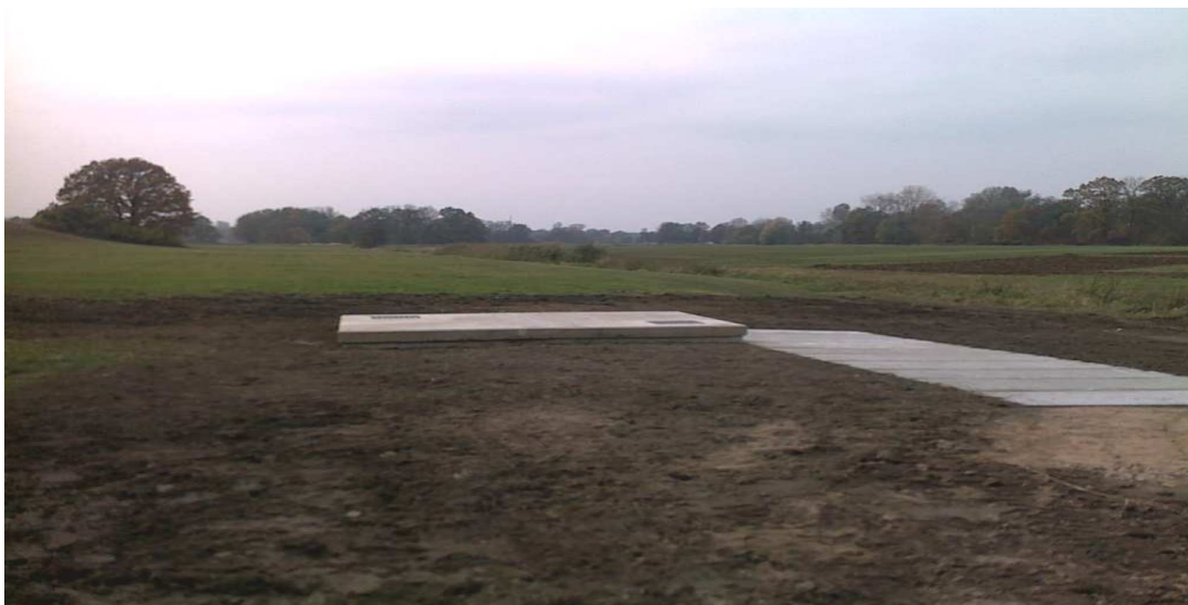
Obr. 25 - dokončená šachta s konečnou úpravou terénu
