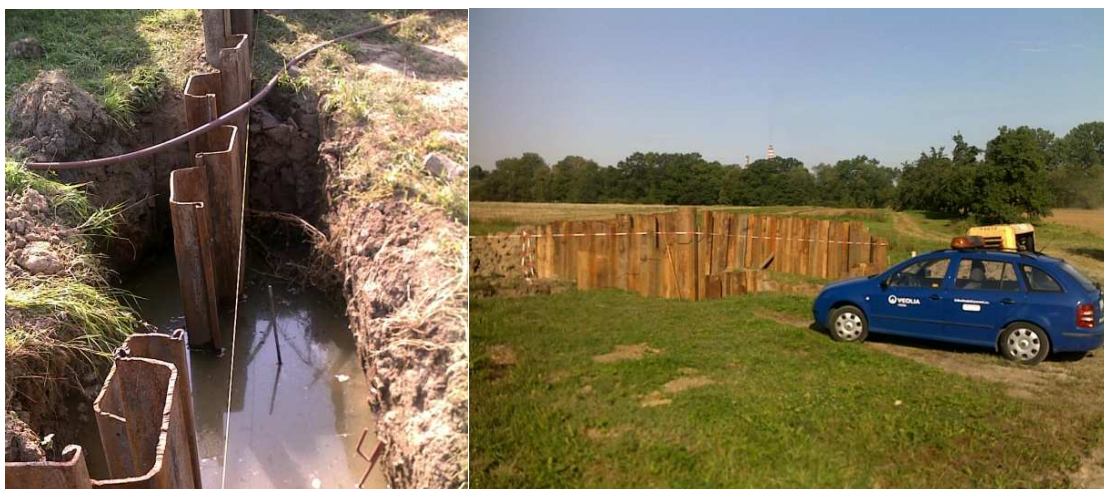
Obr. 19 - zaberaněné štětovnice Larsen po obvodu budoucí šachty
