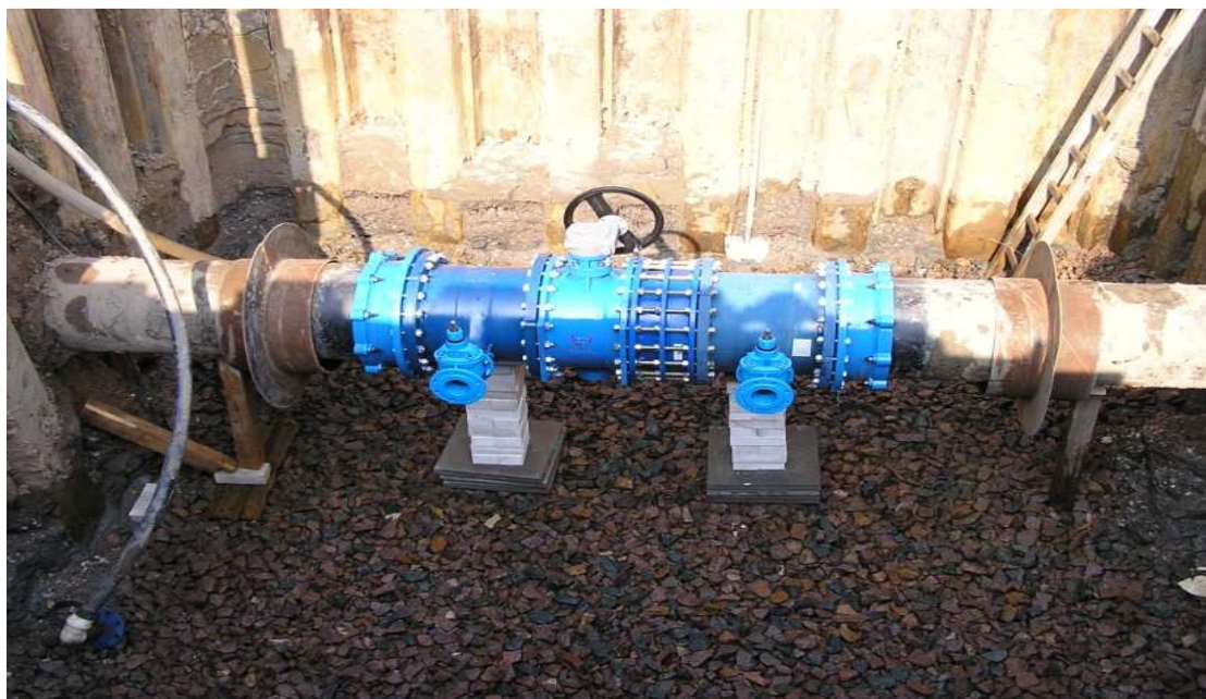
Obr. 22 - provizorní podkladní bloky
