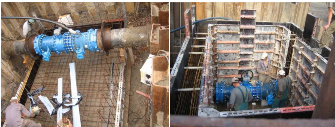
Obr. 23 - uložení výztuže dna a bednění
