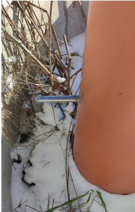
Obrázek 2.2: Nivelační značka VL4 509.01 (vlastní)
