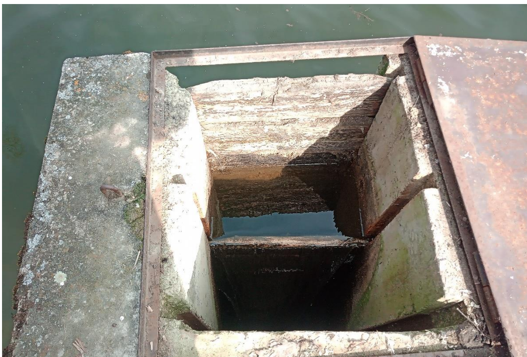
Příloha č. 6. Výpust rybníka s požerákem
