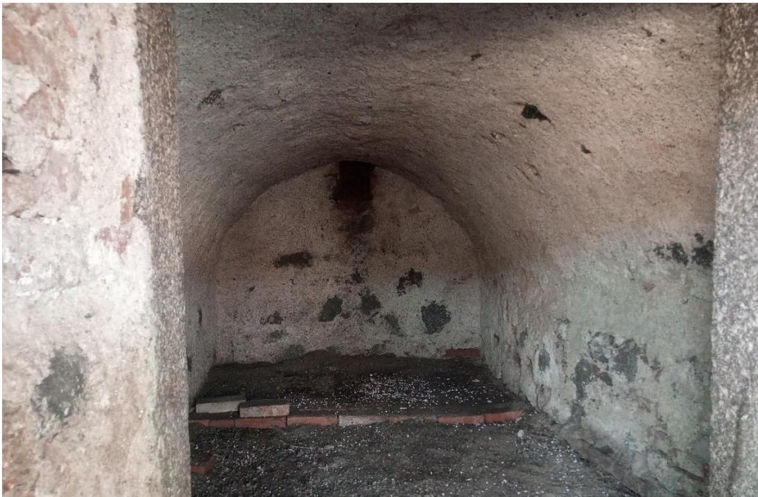
Obr. č. 17: Vnitřní prostor sklepa, foto autor
