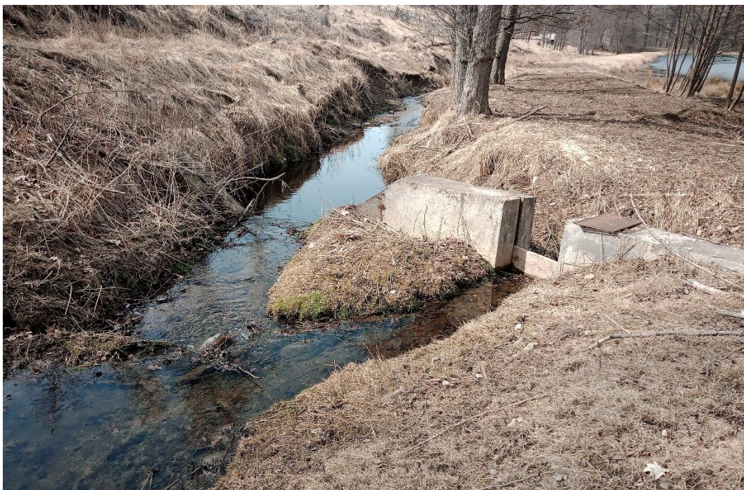
Příloha č. 6. Výpust rybníka s požerákem
