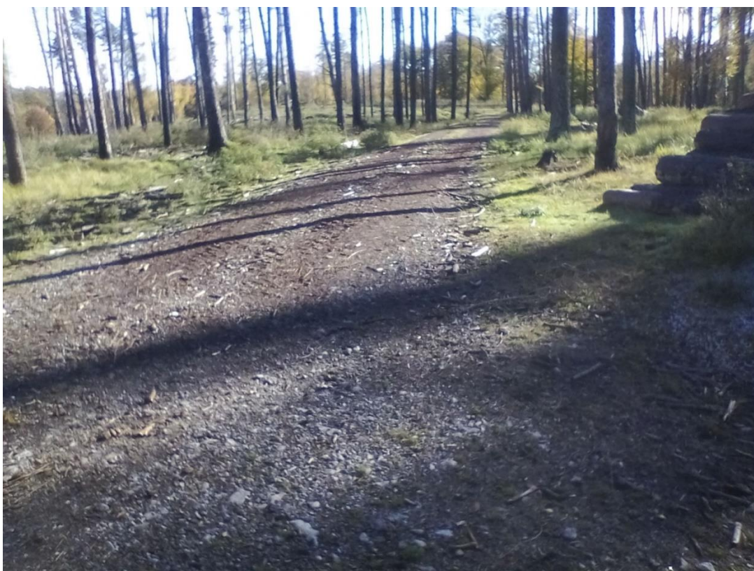
Příloha č. 9. Mostek pod lesní cestou L1
