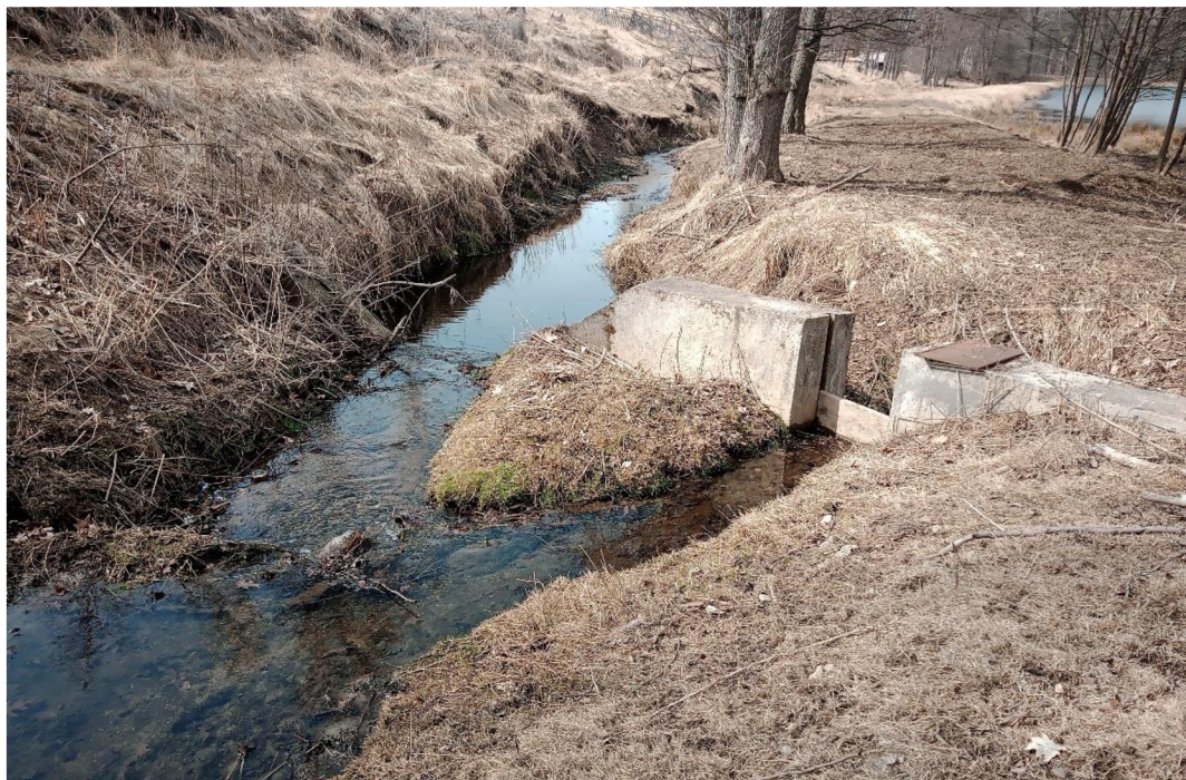
Příloha č. 6. Výpust rybníka s požerákem
