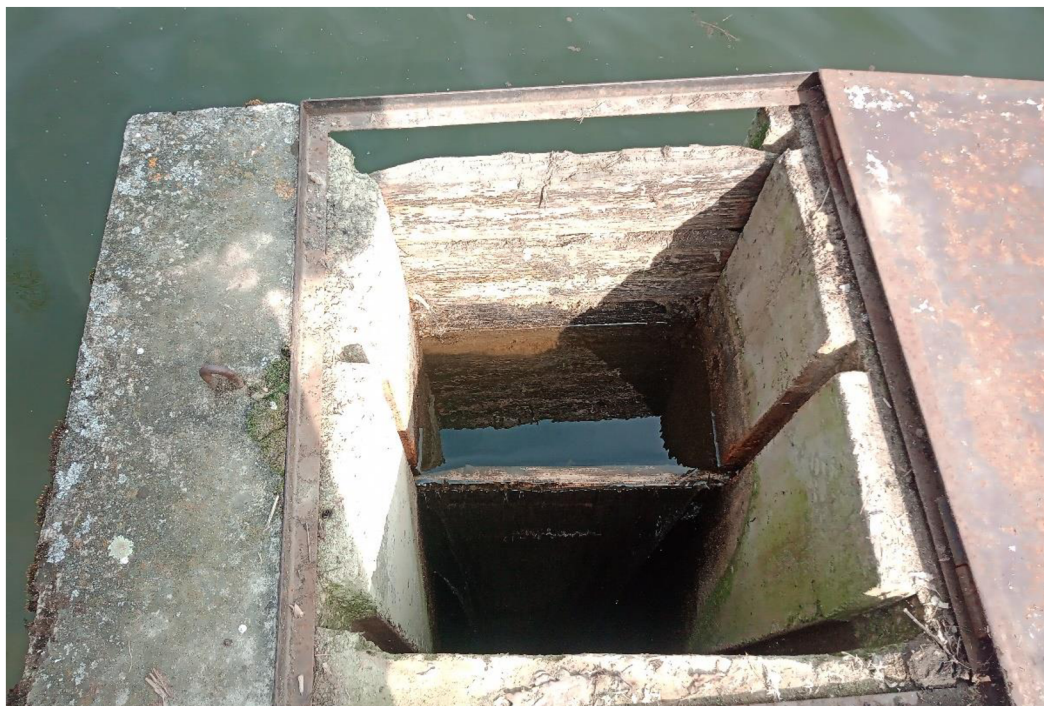
Příloha č. 6. Výpust rybníka s požerákem
