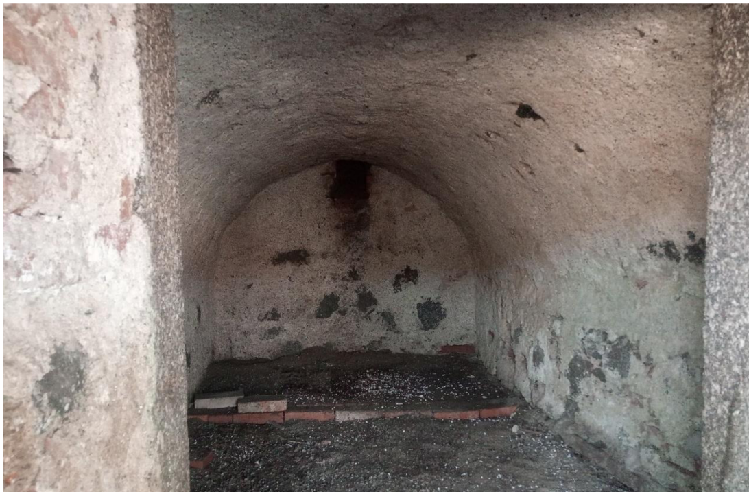
Obr. č. 17: Vnitřní prostor sklepa, foto autor
