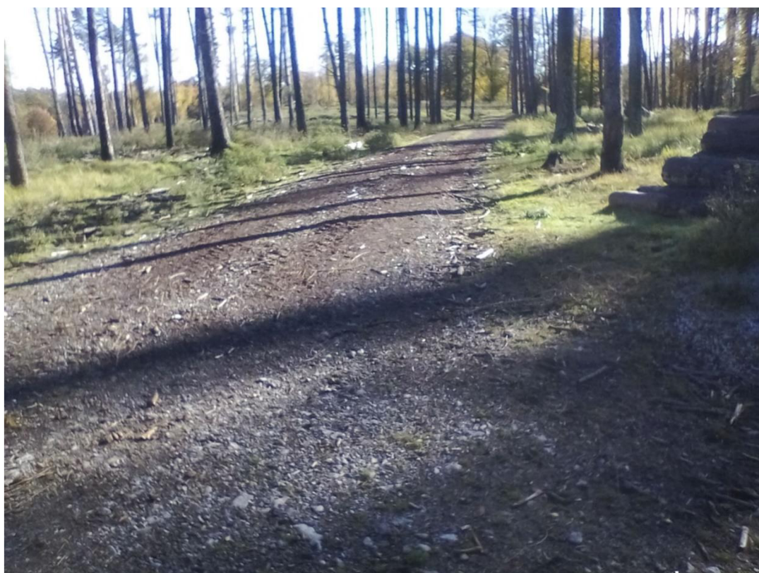
Příloha č. 9. Mostek pod lesní cestou L1
