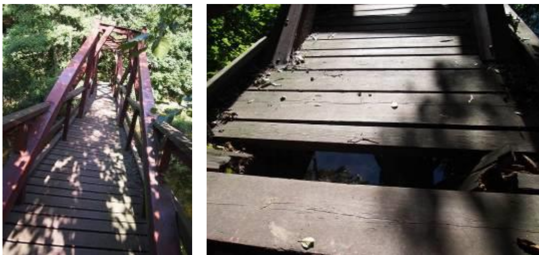
Obrázek 12, 13 - NS Jakuba Míly, Žernovská lávka – celkový pohled a detail
