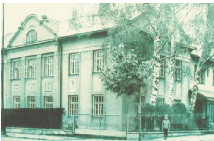
Obr. 14 : Budova knoflíkárny ve 20. letech 20. století
