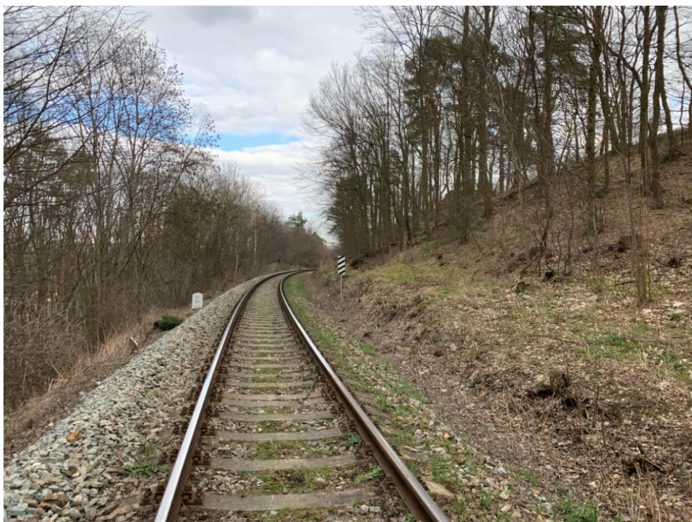
Skalní odřez v km 52,050
