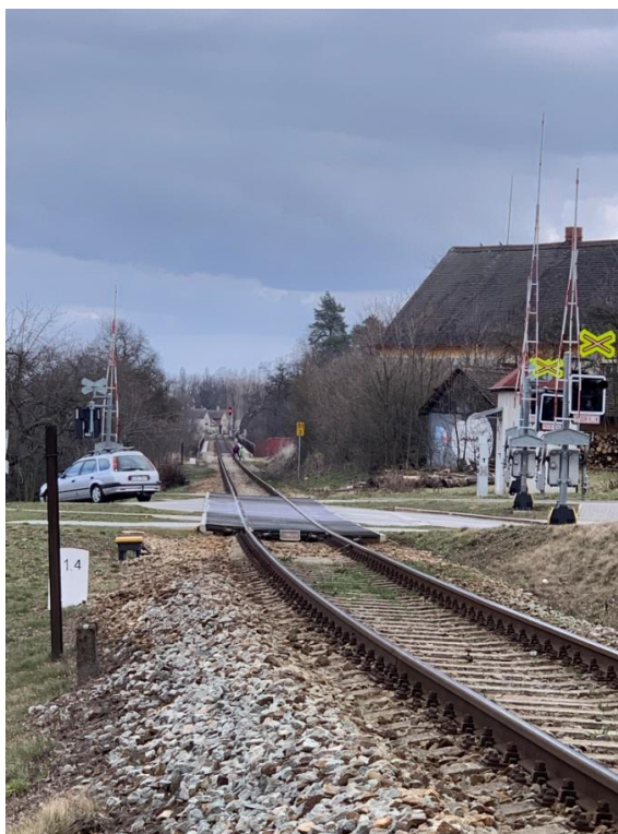
Přejezd s komunikací I/23 (P3865) v km 51,361
