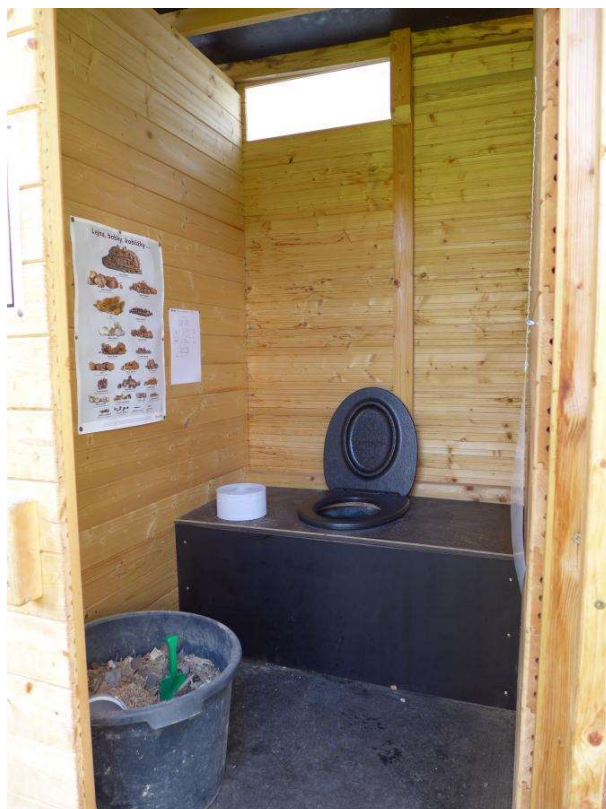
Obrázek č. 4: Kompostovací toaleta (Zdroj: [38])
