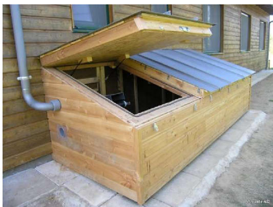
Obrázek č. 5: Vnější kompostovací komora z kompostovací toalety u domu ve Francii (Zdroj: [28])
