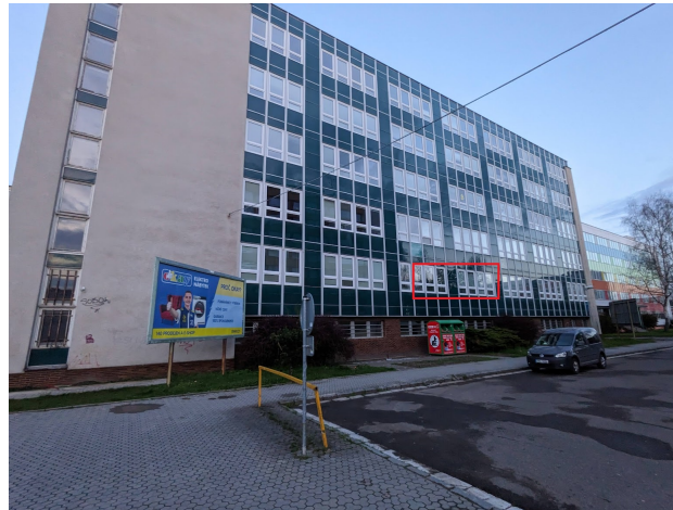
Obrázek 24: Budova školy Zdroj: [autor]
