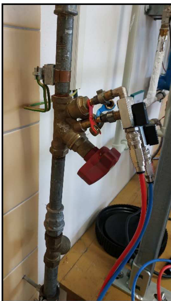
Obr. 16 – Vyvažovací ventil STAD
