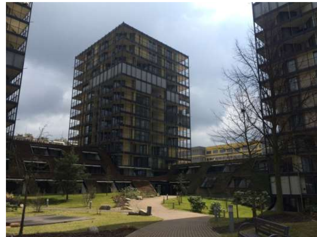
Obr. 37: Pohled na zatravněné střechy (foto: autor, 2015)
