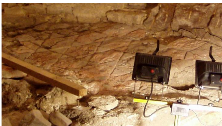
Obr. 51: Poškození keramické dlažby vlivem vlhkostní roztažnosti (převzato z: Kloužková 2002)
