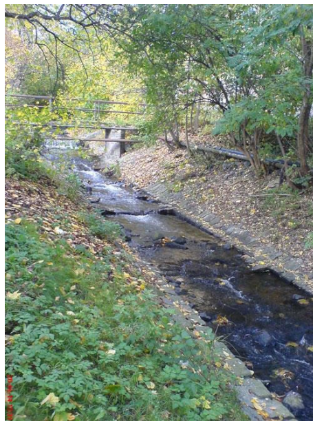
Obr. č. 38, 39 – Opevnění koryta kameninou ve tvaru U v horní části úseku; Střední část úseku v provedení na sucho - lichoběžníkový profil (autor 2014).
