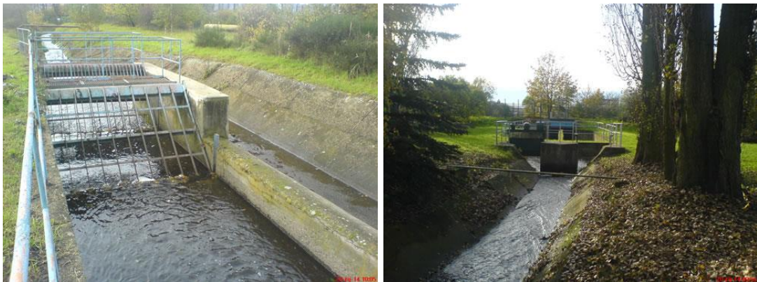
Obr. č. 46, 47 – Pevné česle s bezpečnostním obtokem; povodňový objekt na konci sledovaného úseku (autor 2014).
