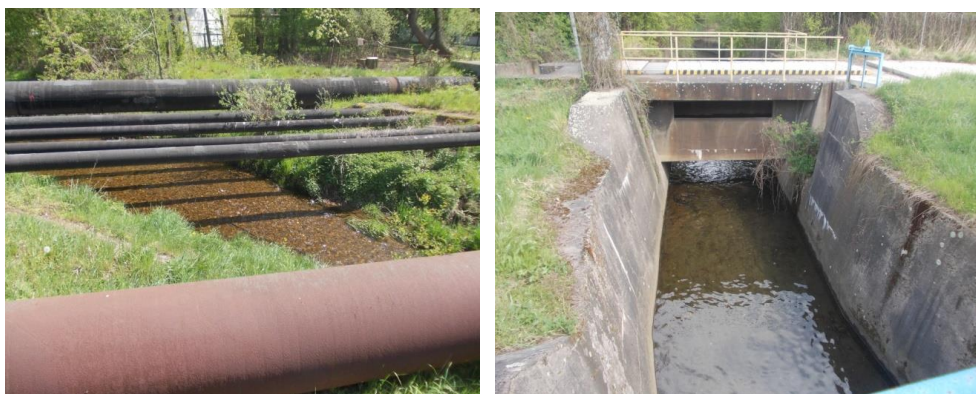
Obr. č. 54, 55 – Na levém obrázku křížení potoka produktovody; Pravý obrázek křížení potoka betonovým korytem Zpětného toku, foceno ze šachet, které slouží pro uložení potrubí surové vody (autor 2014).
