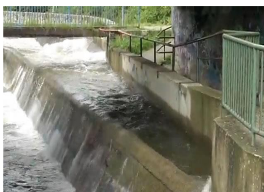
Obr. č. 40, 41 – Havarijní přepad v dolní části úseku; Zaplněné koryto při PVA 2-3 stupně z 3. 6. 2013 (autor + převzato z youtube.cz 2014).
