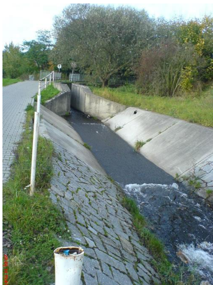
Obr. č. 42, 43 – Skluz po výstupu ze zúženého profilu; Úprava břehů v dolní části úseku (autor 2014).
