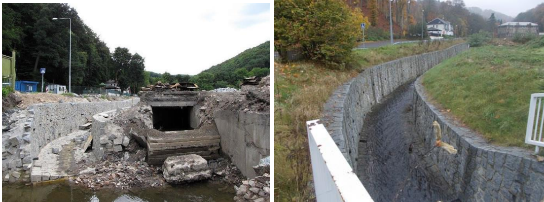
Obr. č. 34, 35 – Na levém obrázku současně budované nové koryto a zahrazené staré koryto, potok v tuto dobu protékal vybagrovanou strouhou vedle starého koryta. Na pravém obrázku dokončená úprava koryta těsně před vstupem do zakrytí (Aulický a Setvák 2010; autor 2014).
