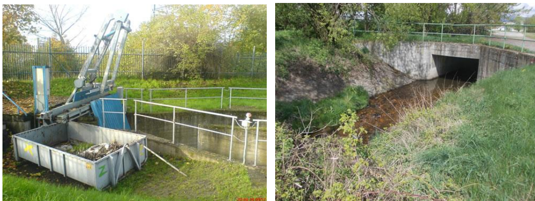
Obr. č. 48, 49 – Vlevo vstup do zakryté části opatřený strojně stíranými česlemi, Pravý obrázek výstup ze zakrytí v dolní části úseku pod Petrochemií (autor 2014).
