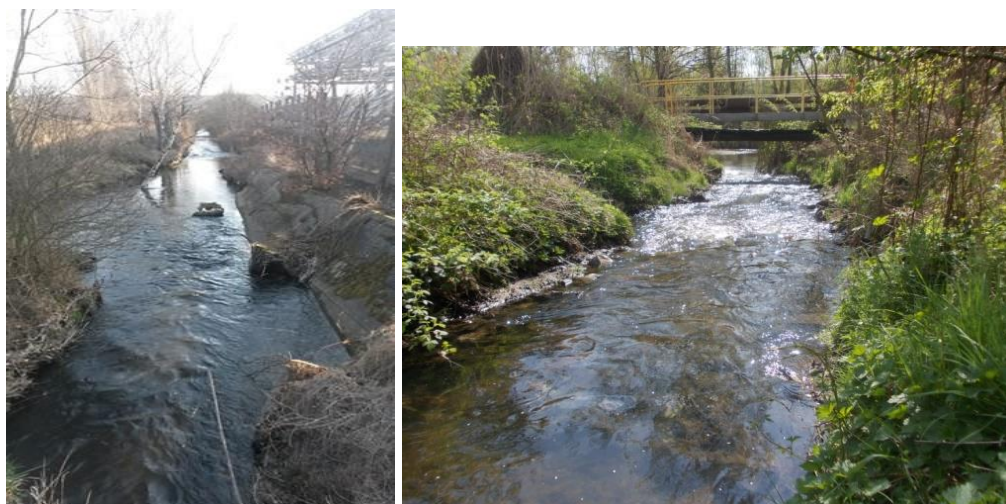
Obr. č. 58, 59 – Na levém obrázku střední část úseku – betonové monolitické opevnění břehu; Na pravém obrázku závěrečná část úseku, v levé části havarijný přepad ze systému dešťové kanalizace Unipetrolu (autor 2014).
