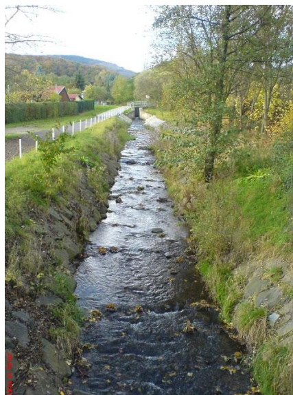
Obr. č. 42, 43 – Skluz po výstupu ze zúženého profilu; Úprava břehů v dolní části úseku (autor 2014).
