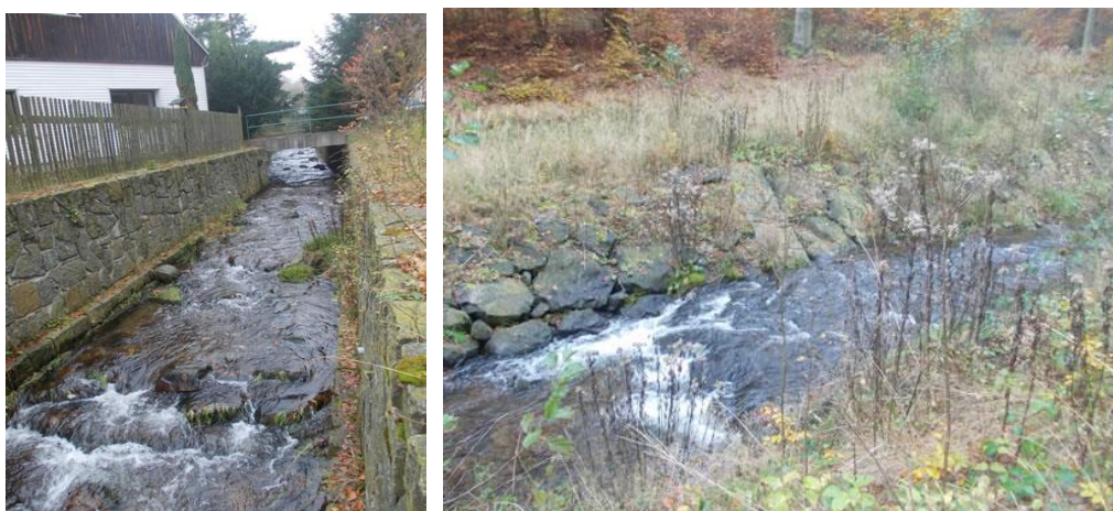
Obr. č. 22,23 – Vlevo úprava břehů a dna v horní části sledovaného úseku; Na pravém obrázku opevnění břehů balvany a přibližně v prostřední části obrázku vybudován zpevňující práh (autor 2014).
