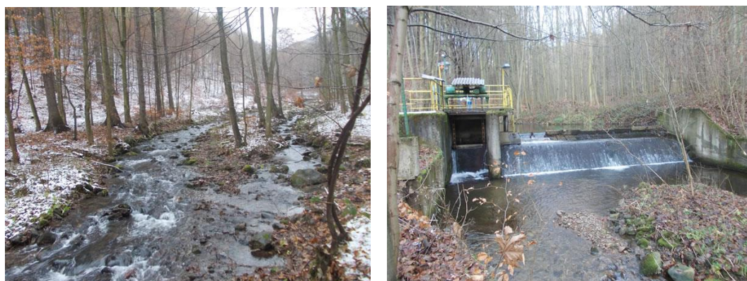
Obr. č. 20, 21 – Na levém obrázku viditelné rozdělení koryta potoka; na pravém obrázku stavidlový objekt se stupněm na konci sledovaného úseku (autor 2014).
