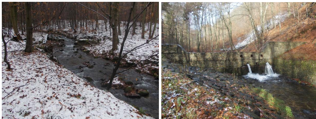
Obr. č. 18, 19 – Koryto potoka zanesené balvany; na pravém obrázku vybudovaná hráz ke zpomalení a akumulaci vody (autor 2014).
