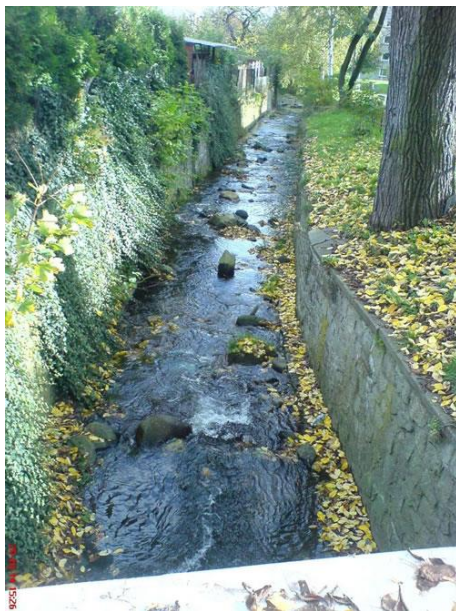
Obr. č. 38, 39 – Opevnění koryta kameninou ve tvaru U v horní části úseku; Střední část úseku v provedení na sucho - lichoběžníkový profil (autor 2014).
