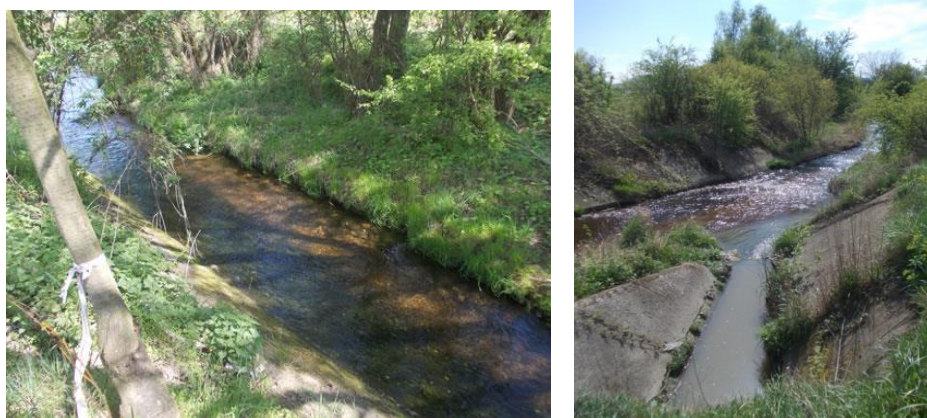
Obr. č. 52, 53 – Na levém obrázku zarůstání panelových břehů; Na pravém obrázku havarijní přepad z potrubí splaškové vody pro ČOV Litvínov (autor 2014).
