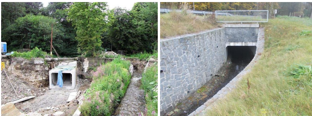
Obr. č. 30, 31 – Na levém obrázku budování přeložky koryta a betonový propustek pod silnicí v ulici Tyrše a Fügnera v roce 2010; Na pravém obrázku dokončena přeložka a provedení úpravy opevnění koryta a dna (Aulický a Setvák 2010; autor 2014).
