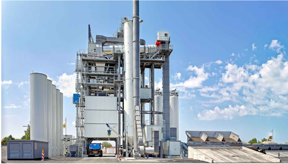
Obr. 4: Šaržová obalovna s paralelním bubnem[21]
