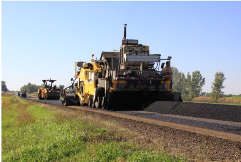
Obr. 2: Provádění recyklace za horka na místě metodou REMIX[19]
