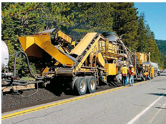
Obr. 1: Recyklační stroj CRMX 2 pro výrobu homogenní směsi[18]
