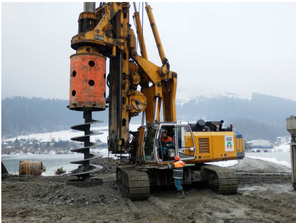
Obr. 3-15: Vrtání piloty šnekem průměru 1350 mm (foto: autor)
