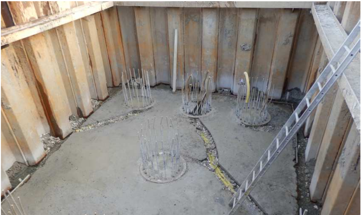
Obr. 3-19: Základová spára s podkladovým betonem a drenáží (foto: autor)
