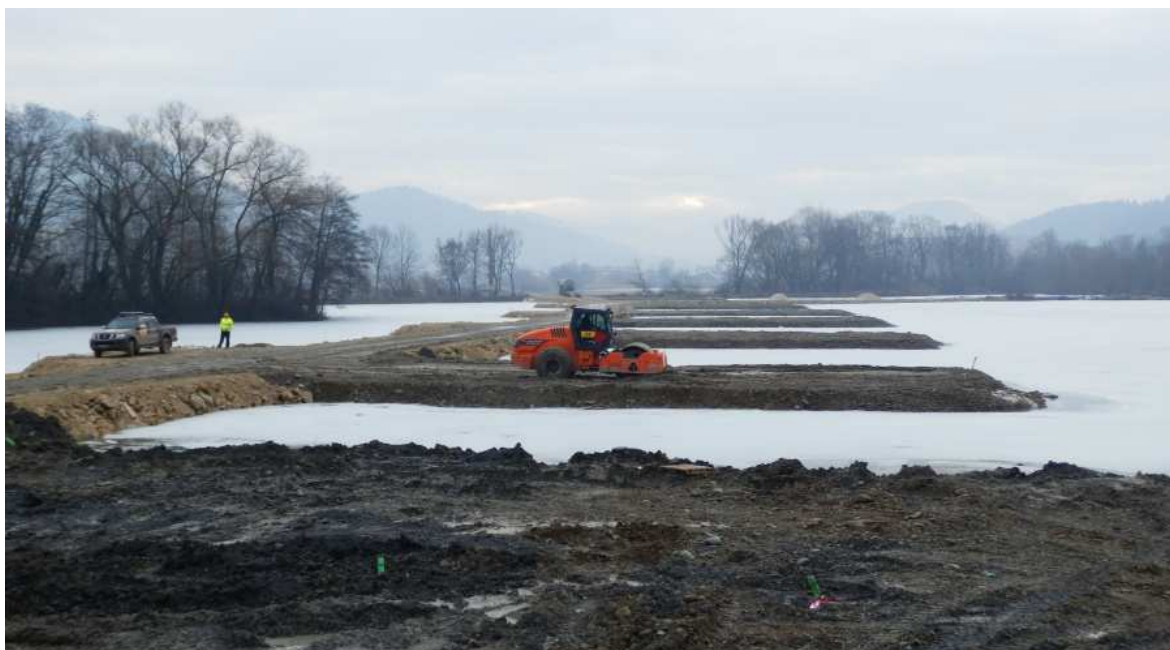
Obr. 3-13: Zhutňování pracovních plošin (foto: autor)
