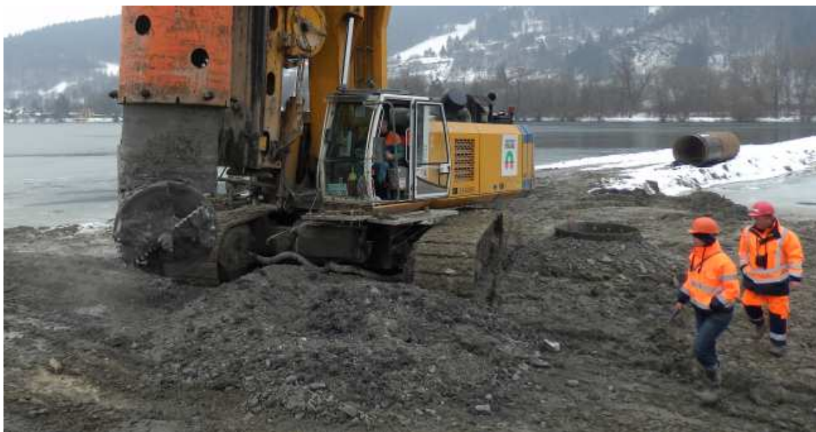
Obr. 3-4: Geologové při vrtání piloty (foto: autor)
