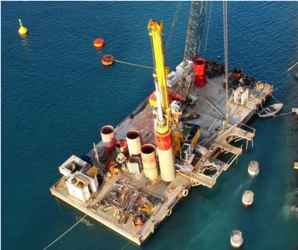
Obr. 2-9: Vrtná souprava na pontonu [6]
