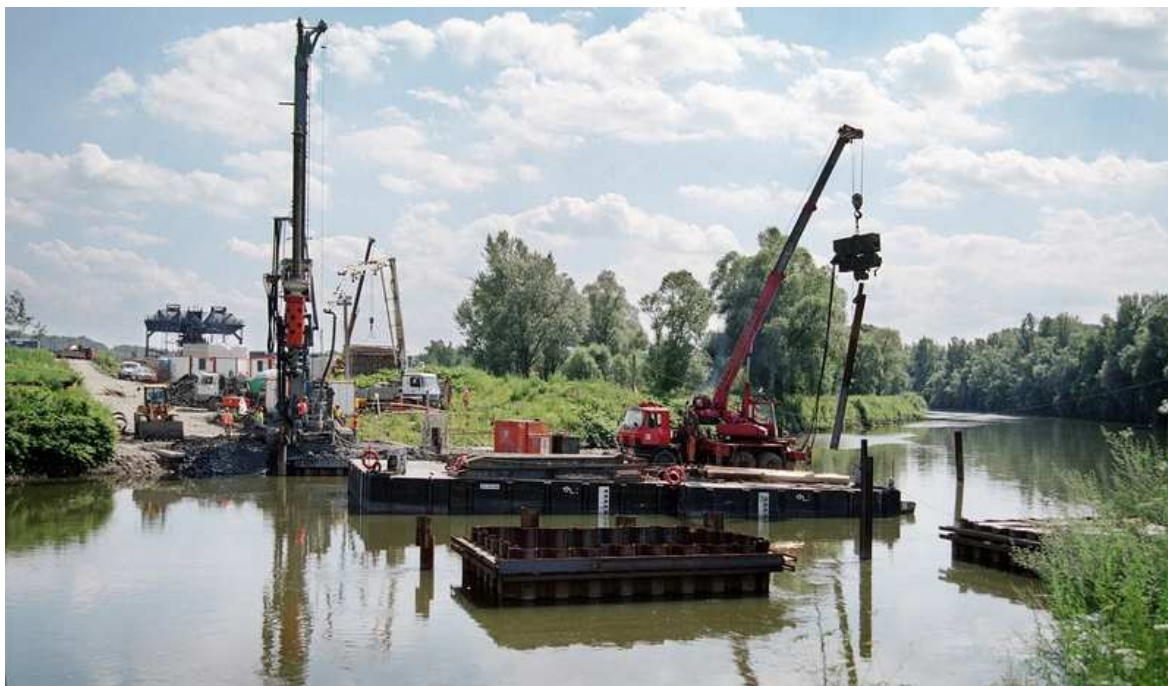
Obr. 2-5: Provádění štětových jímk v řečišti [5]
