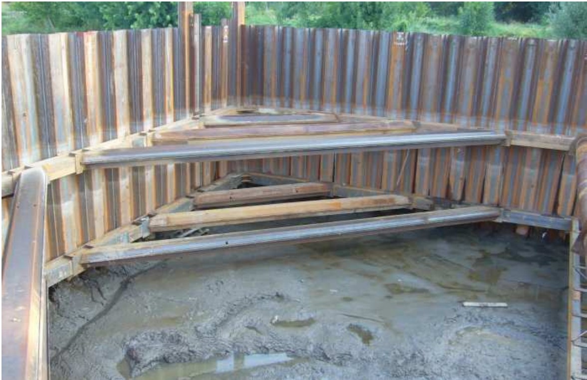
Obr. 2-6: Jímka s rozpěrnými rámy (foto: autor)
