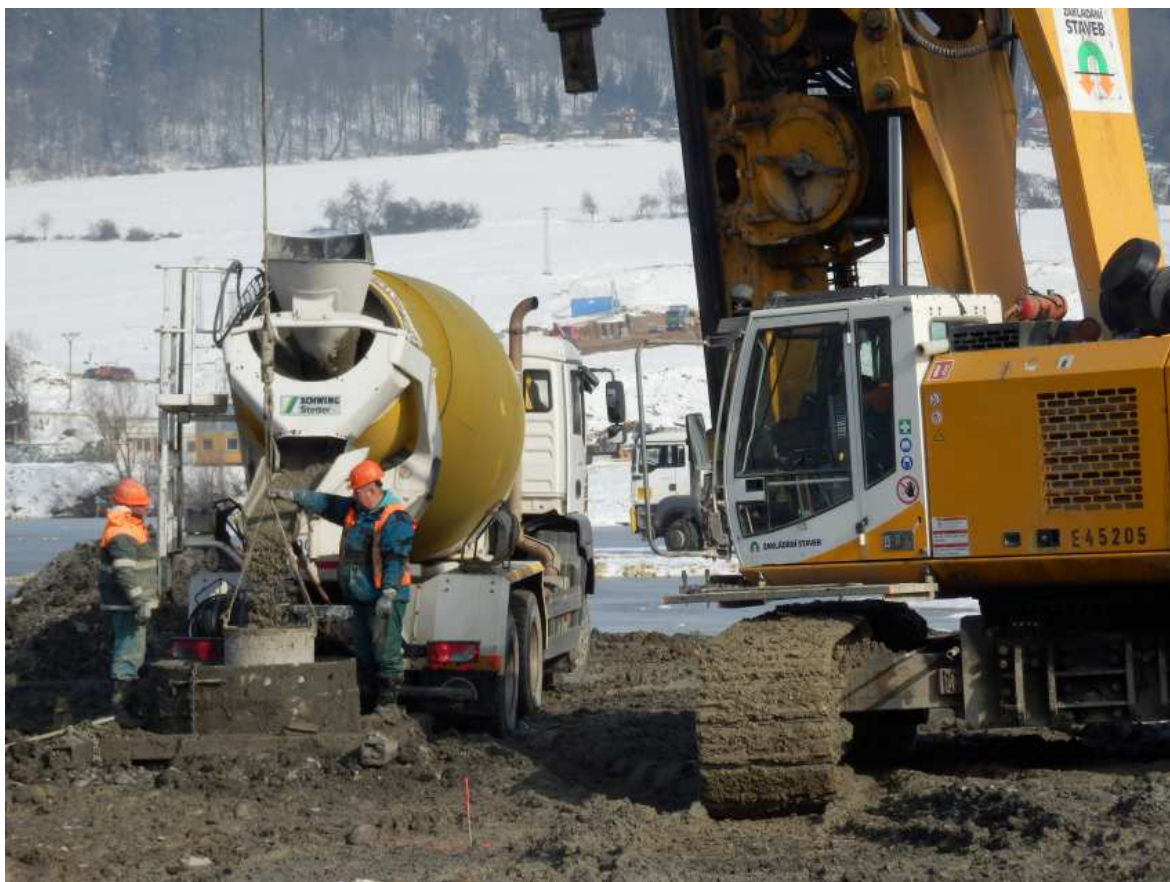
Obr. 3-17: Betonáž piloty pomocí sypákových rour (foto: autor)
