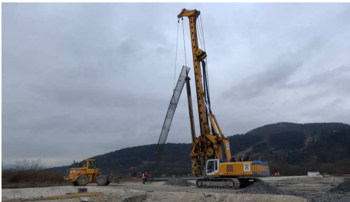
Obr. 3-16: Osazování armokoše piloty (foto: autor)
