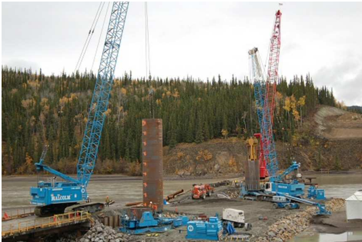
Obr. 2-8: Zakládání mostu přes řeku Tanana na vytvořeném násypu [11]
