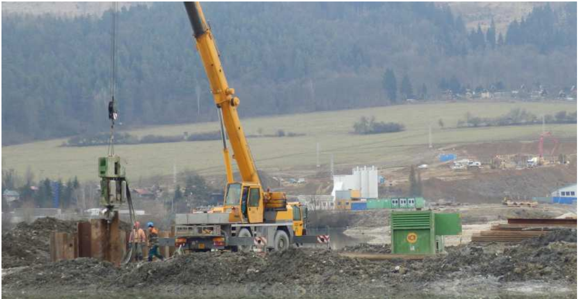
Obr. 3-18: Beranění štětovnic (foto: autor)
