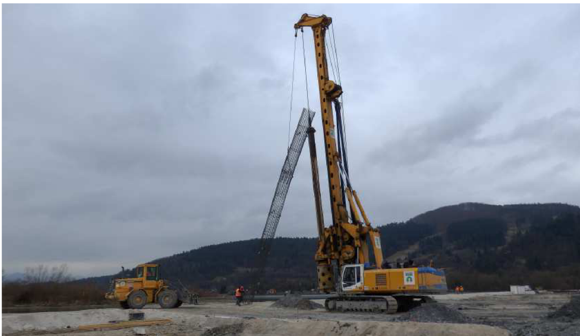
Obr. 3-16: Osazování armokoše piloty (foto: autor)
