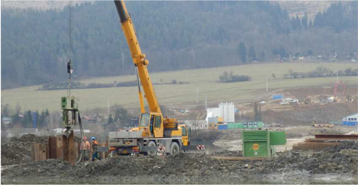
Obr. 3-18: Beranění štětovnic (foto: autor)
