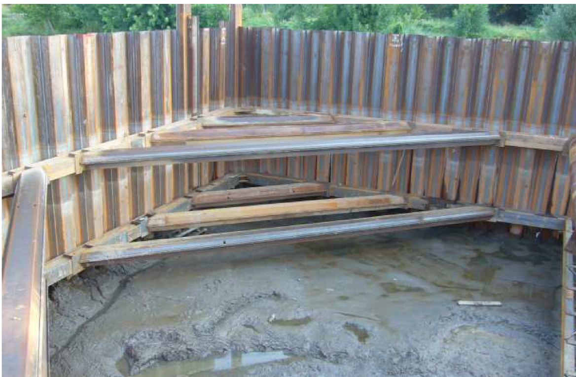
Obr. 2-6: Jímka s rozpěrnými rámy (foto: autor)
