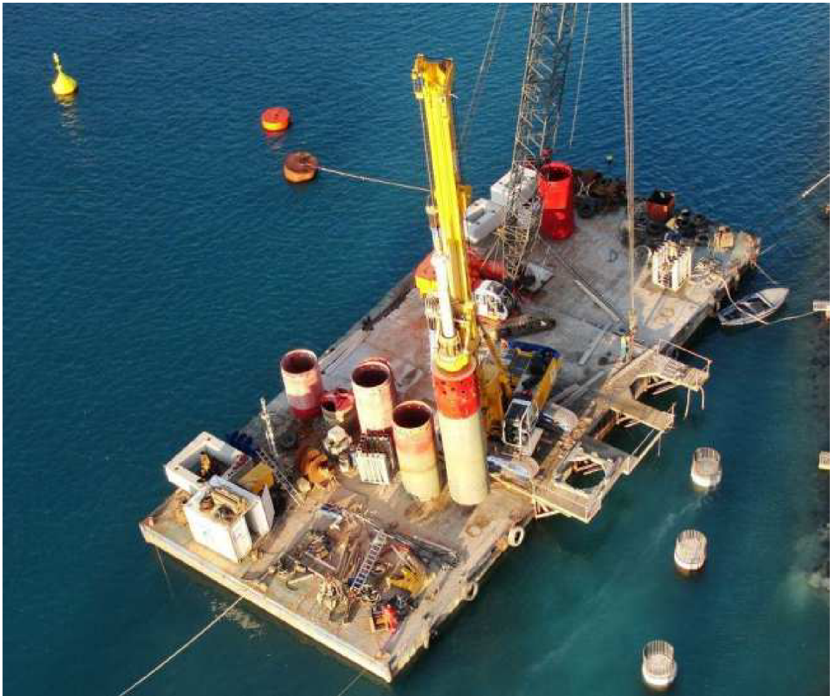
Obr. 2-9: Vrtná souprava na pontonu [6]
