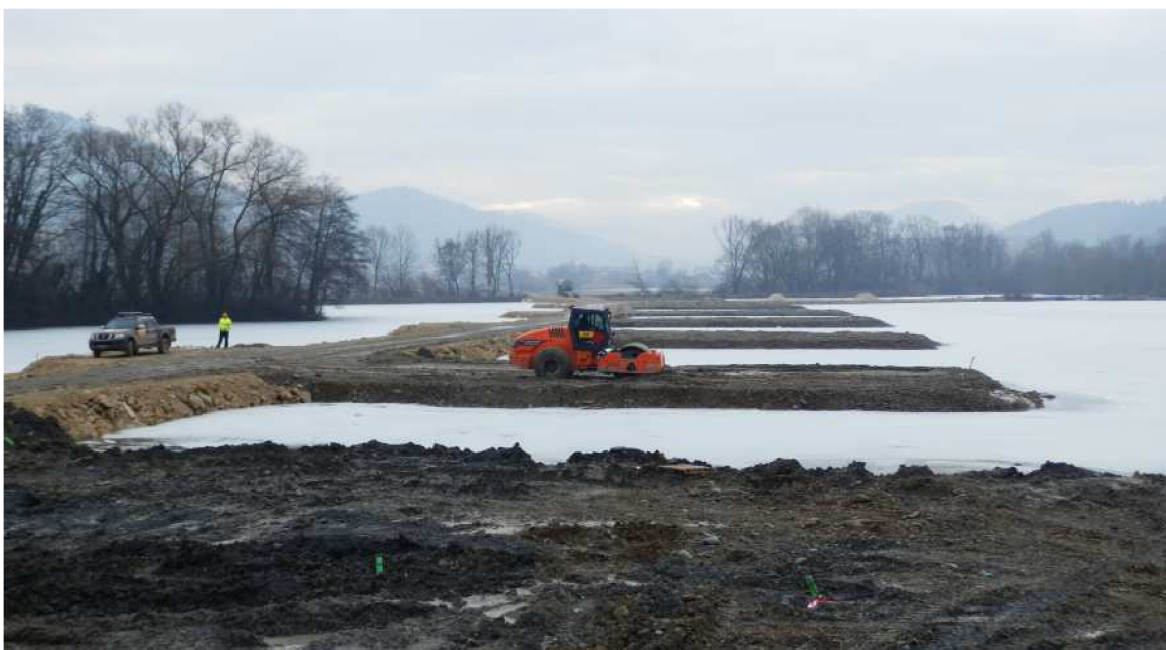
Obr. 3-13: Zhutňování pracovních plošin (foto: autor)
