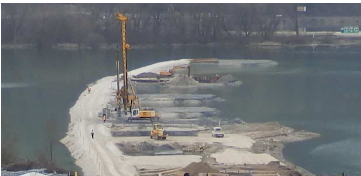
Obr. 2-7: Násyp pro výstavbu dálničního mostu přes vodní nádrž (foto: autor)
