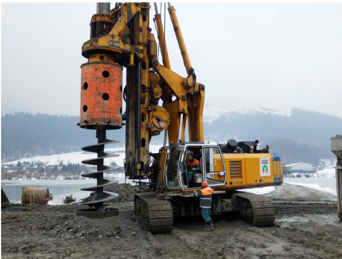
Obr. 3-15: Vrtání piloty šnekem průměru 1350 mm (foto: autor)
