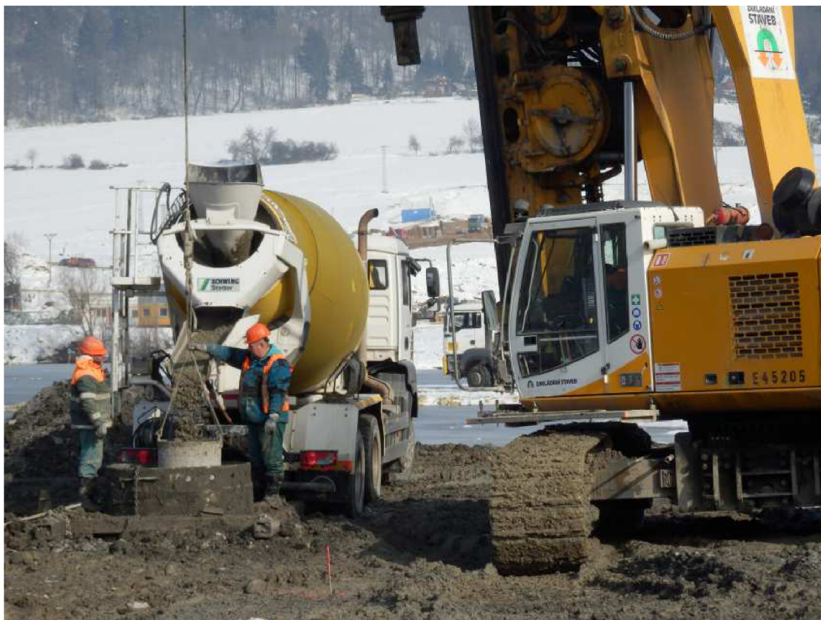
Obr. 3-17: Betonáž piloty pomocí sypákových rour (foto: autor)
