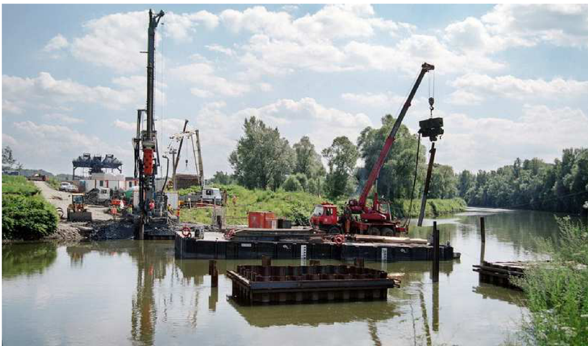
Obr. 2-5: Provádění štětových jímek v řečišti [5]
