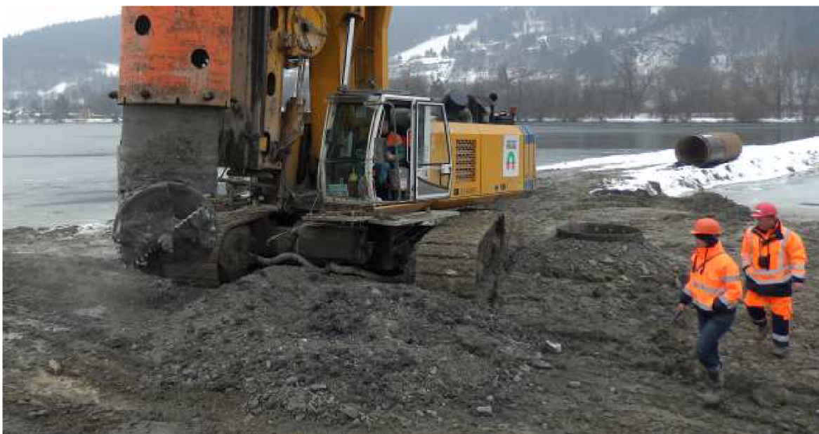
Obr. 3-4: Geologové při vrtání piloty (foto: autor)
