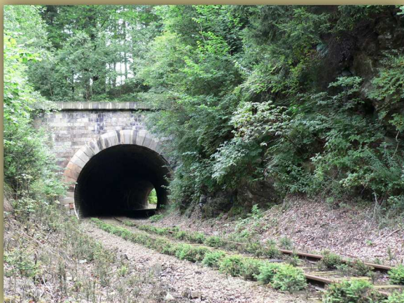
Železniční tunel u zastávky Vlaské.
