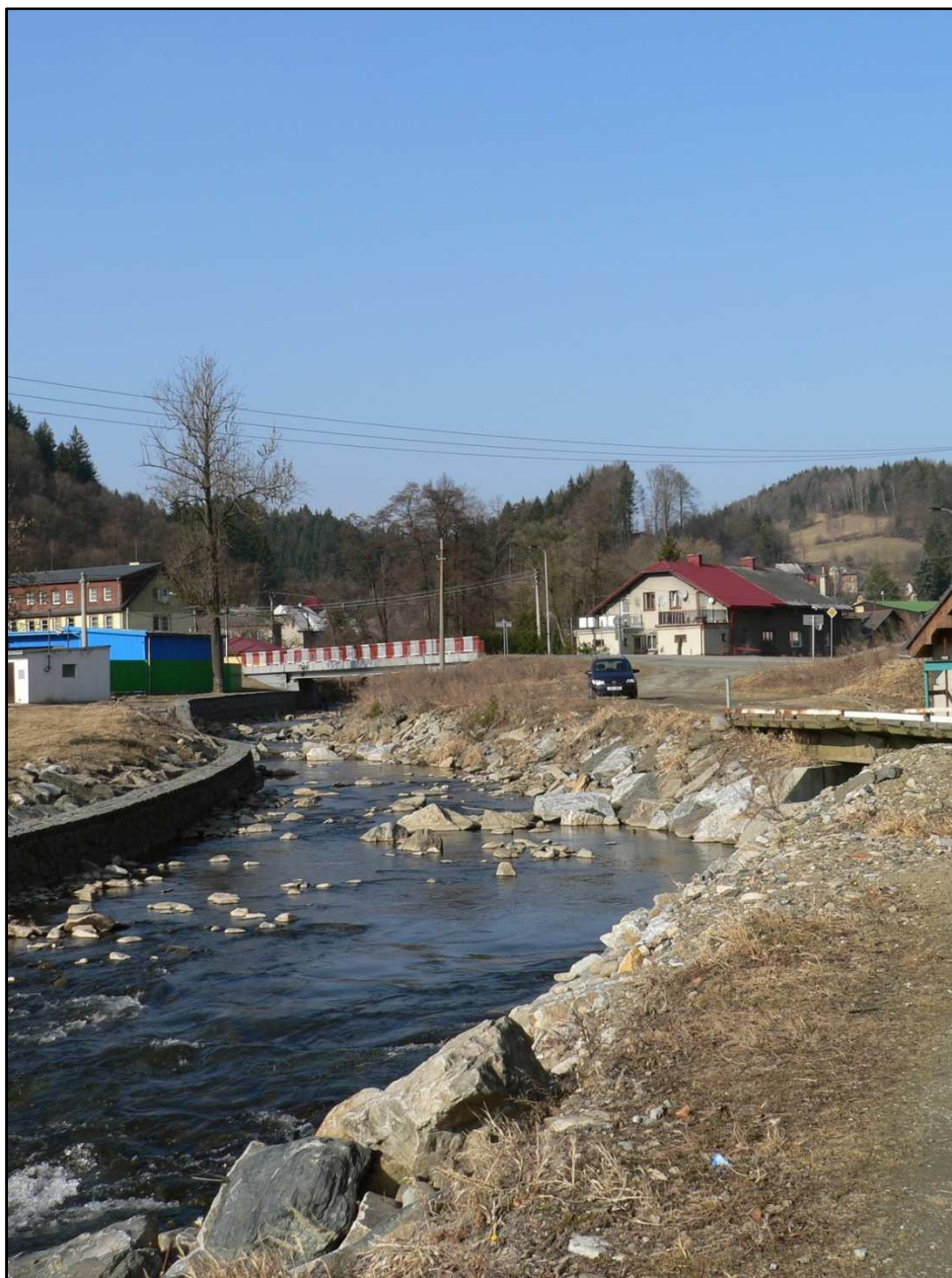
Obr. 83: Koryto Branné před soutokem s Moravou; Foto: V. Koubová, 30. 3. 2011
