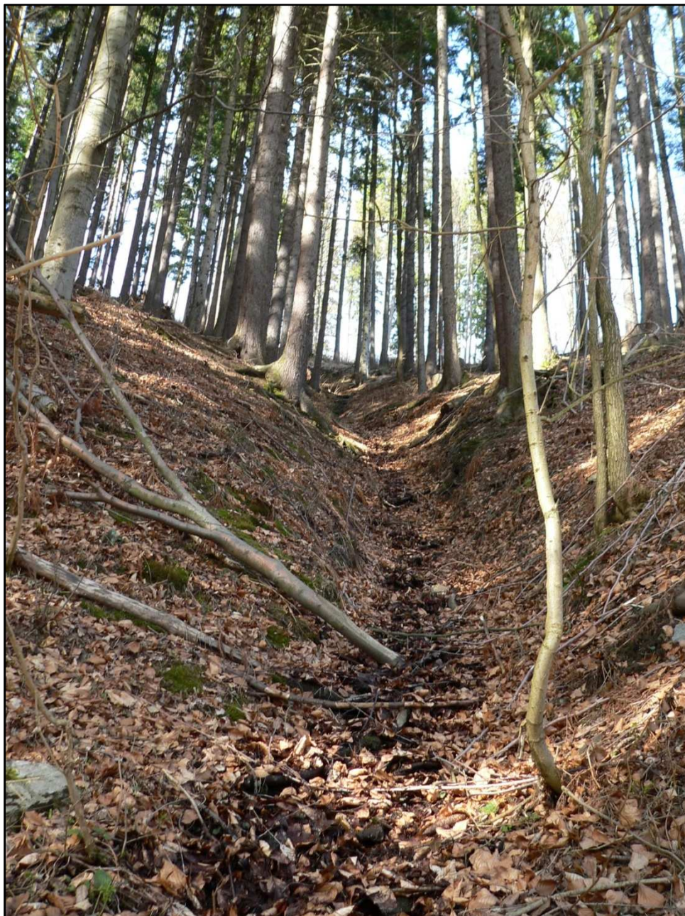
Obr. 51: Strž typu ovrage; Foto: V. Koubová, 23. 3. 2011
