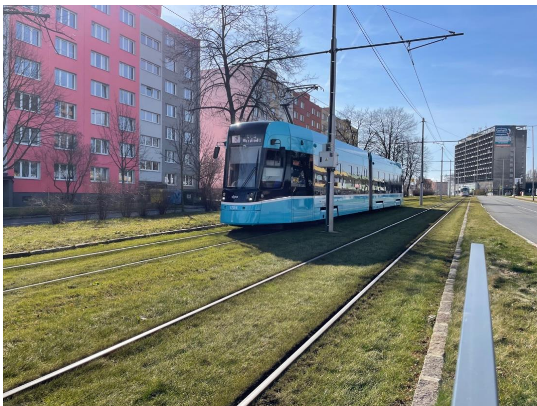
Obr. 20 Tramvajová trať s travním porostem na ulici Výškovická (Štěrbová A., březen 2023)
