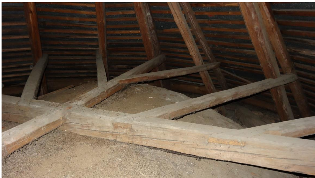
Obr. 18: Pohled na krov nad presbytářem
