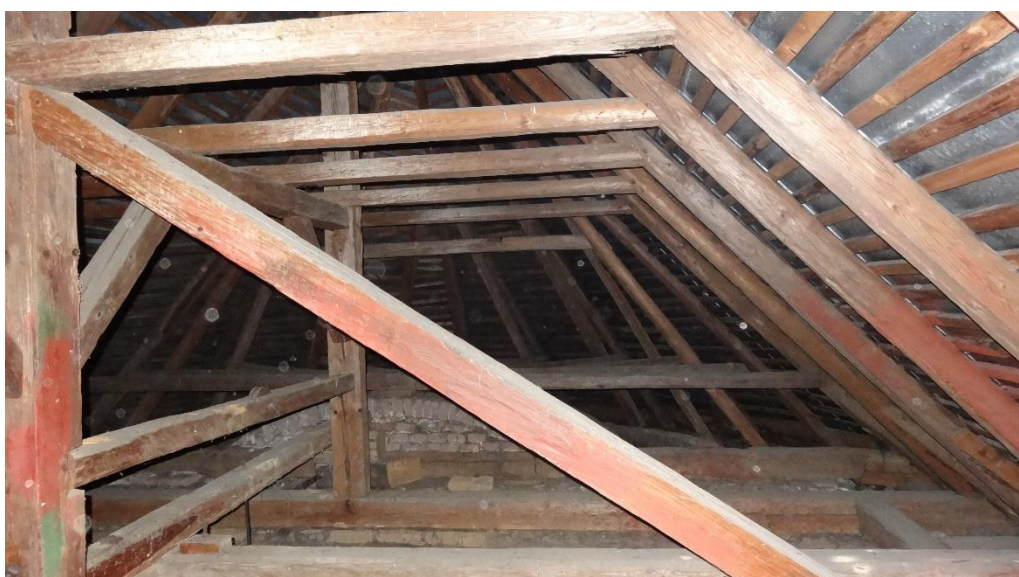
Obr. 19: Čelní (východní) pohled na konstrukci krovu
