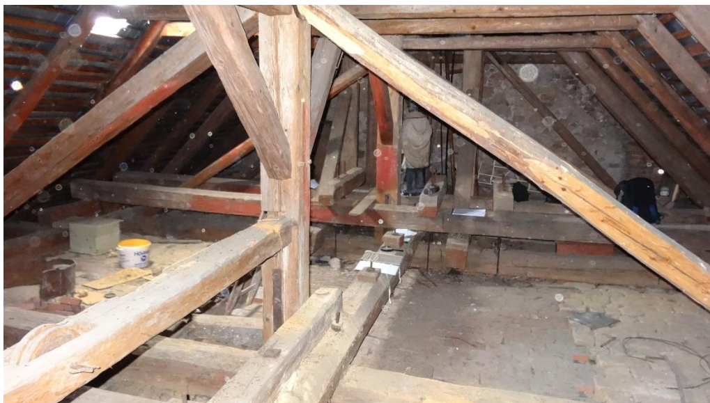
Obr. 20: Zpětný (západní) pohled na konstrukci krovu
