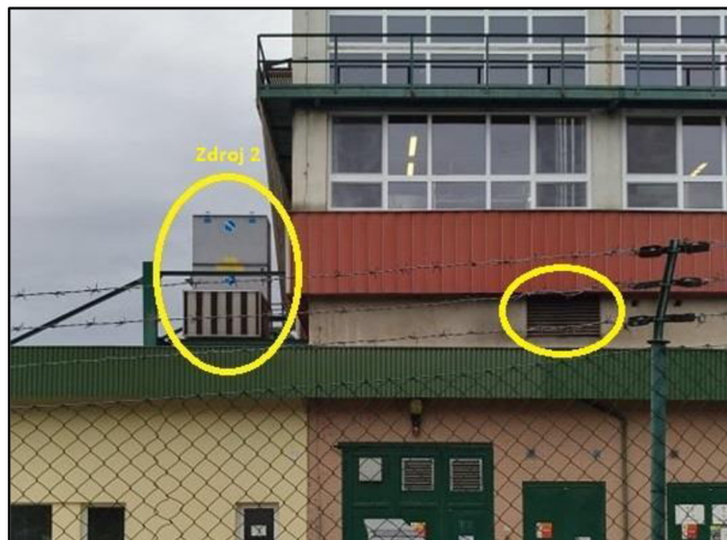
Obrázek 20 – Zdroj 2, kondenzační jednotka + ventilace
