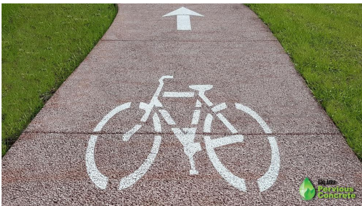
Obr. č. 16: Využití vodopropustného betonu pro cyklostezky [O16]
