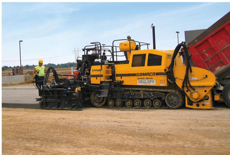
Obr. č. 6: Ukládání čerstvé betonové směsi finišerem [O6]
