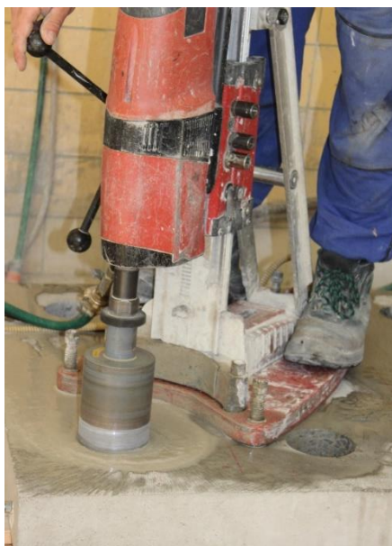
Obr. G-14-2 Odběr jádrového vývrtu z drátkobetonové desky
