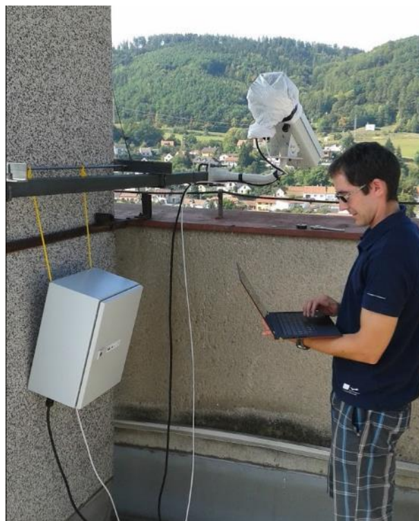
Obr. 6.5: Instalované zařízení pro sledování okružní křižovatky v Blansku z přilehlé výškové budovy.
