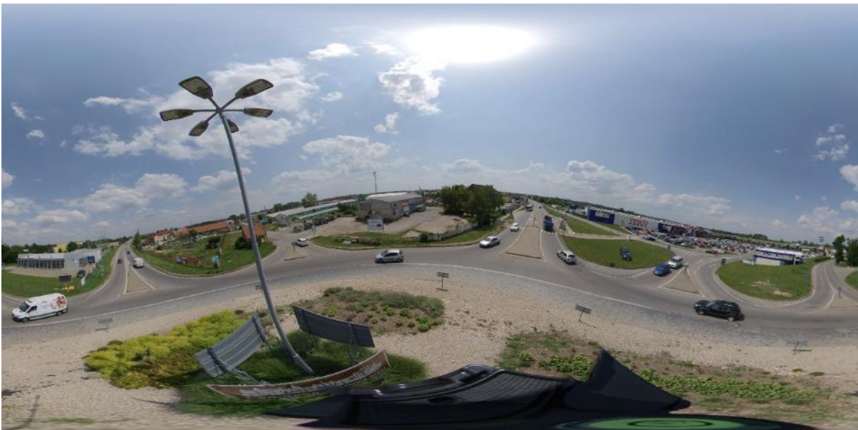
Obr. 6.9: Rozvinutý pohled z kamery s 360° záběrem (JOK Břeclav).
