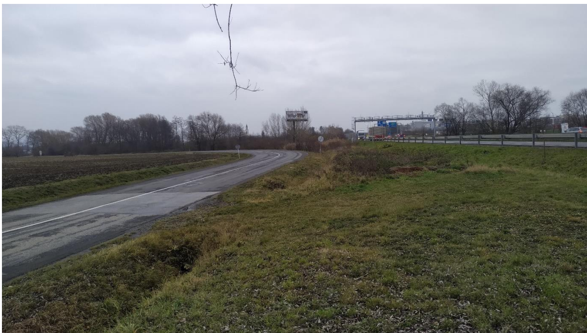
Obr. 13: Pohled na rozdělení císařské cesty a dálnice D35 u obce Křelov.
