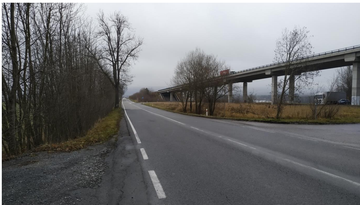
Obr. 33: Pohled na estakádu u kopce Hřebeč ve směru na Moravskou Třebovou. (Foto: Jan Macek, 26. 11. 2019)
