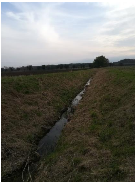
Obr. 26 Úsek SOP_008 - Středně modifikovaný stav (zdroj: archiv autora)
