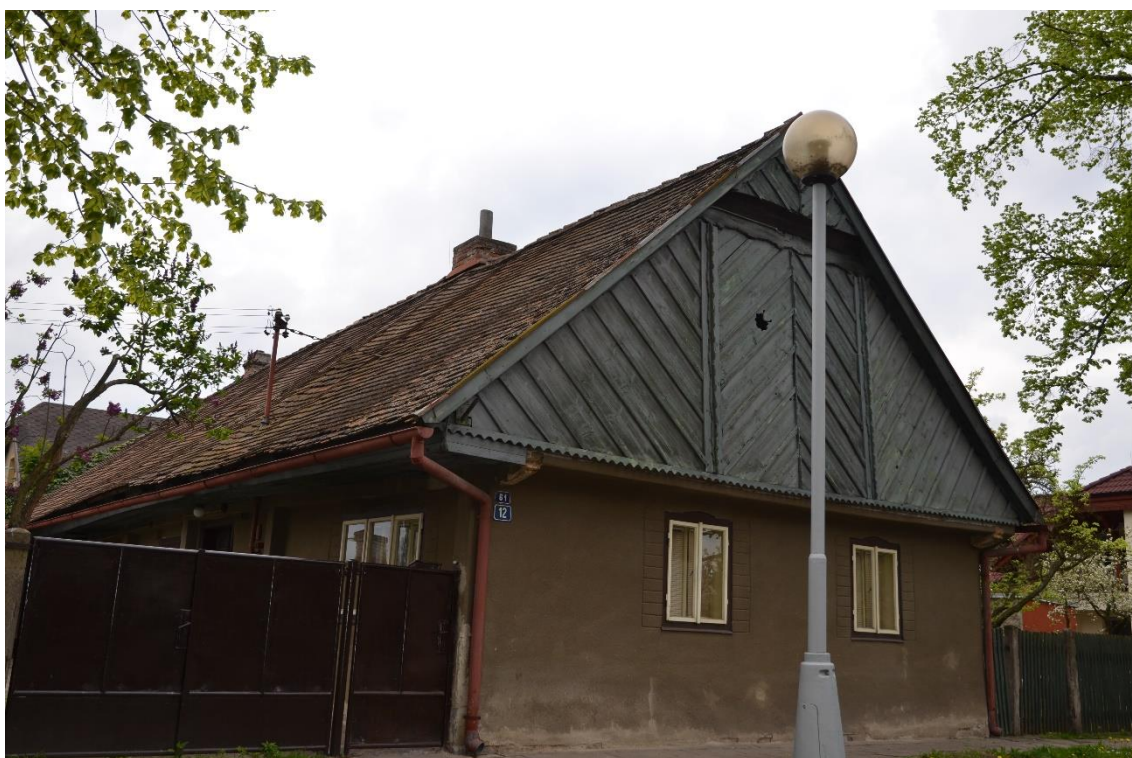
Obrázek 35: Dům čp. 61, ulice Přímská, Malšovice [zdroj: D. Emingerová, 2015]
