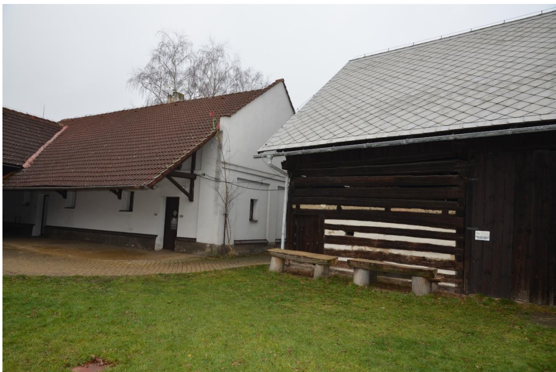
Obrázek 50: Areál Šrámkova statku, stodola a budova místní knihovny (vlevo), Piletice [zdroj: D. Emingerová, 2015]
