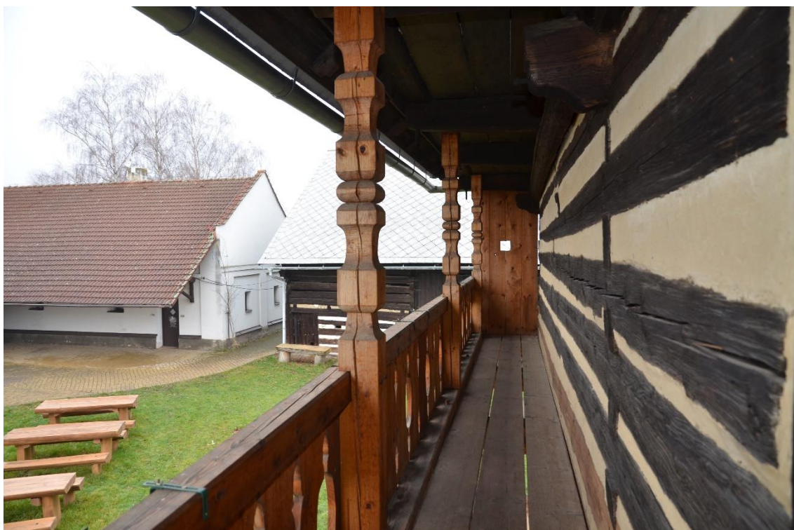
Obrázek 49: Pohled z pavlače na dvůr, Šrámkův statek, Piletice [zdroj: D. Emingerová, 2015]
