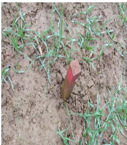
Obr. 5 – Stabilizácia bodov pomocnej meračskej siete dreveným kolíkom
