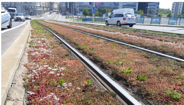
Obr. 3.13 Trať s rozchodníky v Ostravě, červen 2019 [41]
