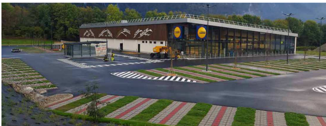
Obr. 3.11 Příklad kombinace zatravnovacích bloků s drenážní dlažbou [37]
