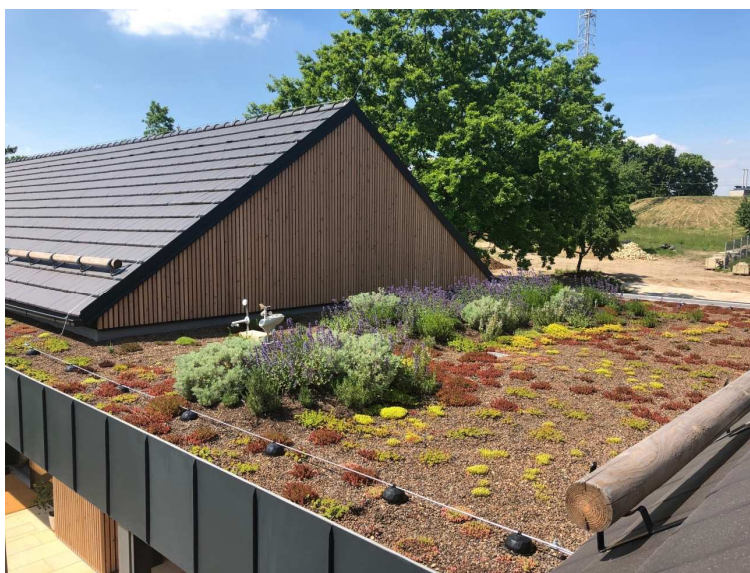
Obr. 3.1 Příklad extenzivní vegetační střechy [36]
