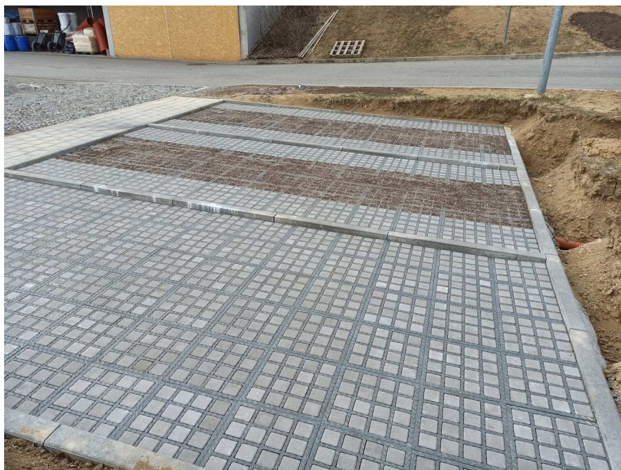
Obr. 4.5 Parkoviště z AS-TTE roštů na pozemcích centra AdMaS (foto po vysetí trávy, v popředí varianta 2, dále varianta 1 ve verzi s a bez biocharu)
