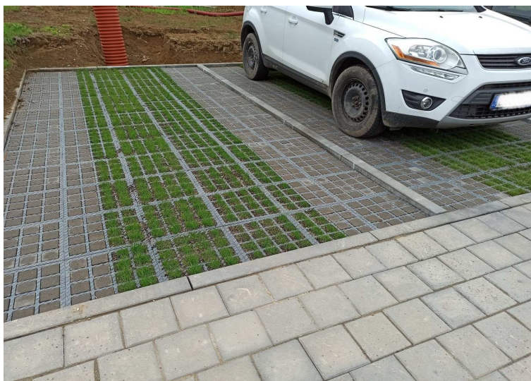
Obr. 4.3 Parkoviště z AS-TTE roštů na pozemcích centra AdMaS po ozelenění
