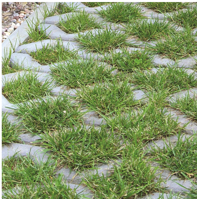
Obr. 3.12 Finální vzhled při použití betonových zatravňovacích dlaždic [38]
