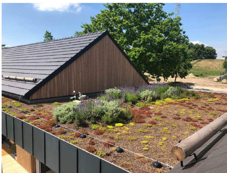
Obr. 3.1 Příklad extenzivní vegetační střechy [36]
