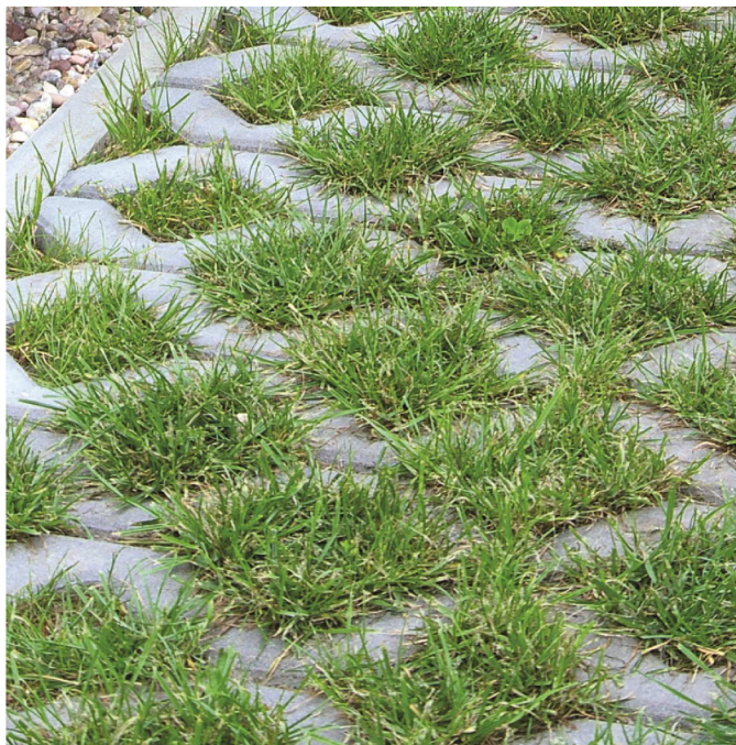
Obr. 3.12 Finální vzhled při použití betonových zatravňovacích dlaždic [38]
