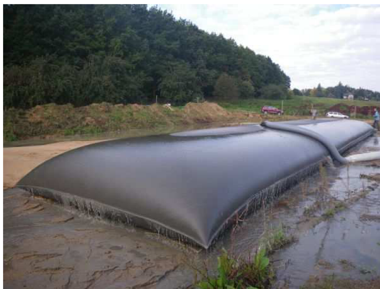
Obr. 2.3 Odvodňovací vak TenCate Geotube [12]
