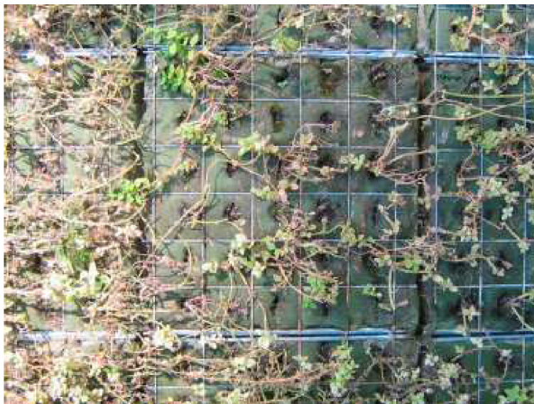
Obr. 3.8 Modulový systém živých stěn s krycí mřížkou[33]
