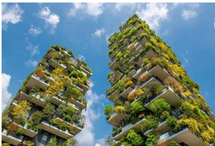
Obr. 3.7 Použití policového systému na věžích Bosco Verticale, Miláno [35]
