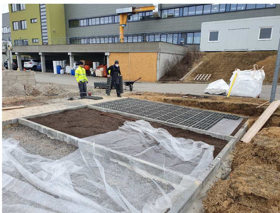
Obr. 4.6 Foto z realizace parkoviště z AS-TTE roštů [45]
