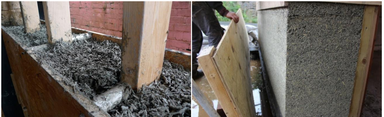
Obr. 34: Vlevo – zhutněný konopný beton v dočasném bednění, vpravo – povrch po odbednění (THE LAST STRAW, 2014; OZHEMP, 2020)
