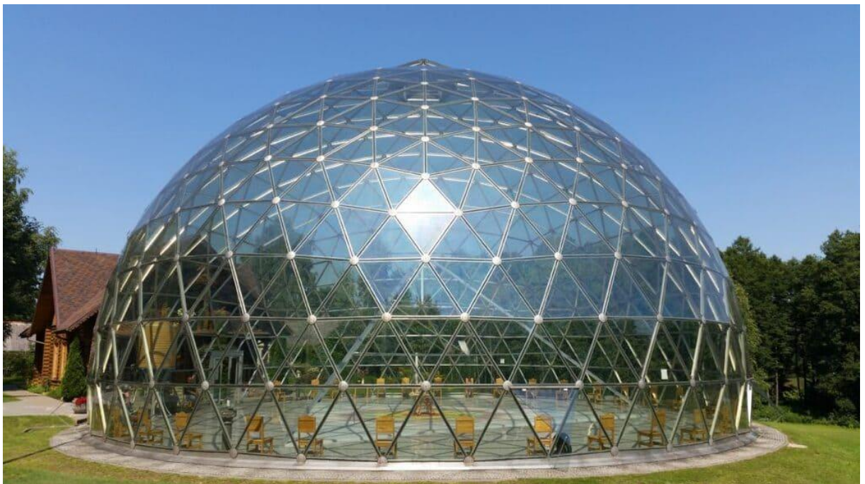
Obr. 32: Kopule s hliníkovou konstrukcí a celoplošným zasklením o průměru 23 m (VIKING DOME, 2023)
