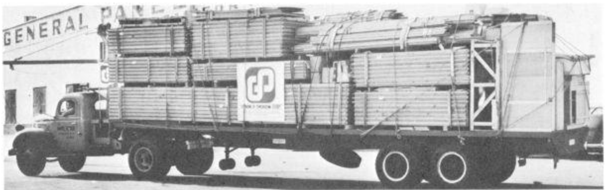
Obr. 15: Přeprava komponentů General Panel System z továrny na staveniště v roce 1947 (The General Panel Corporation, 2021)
