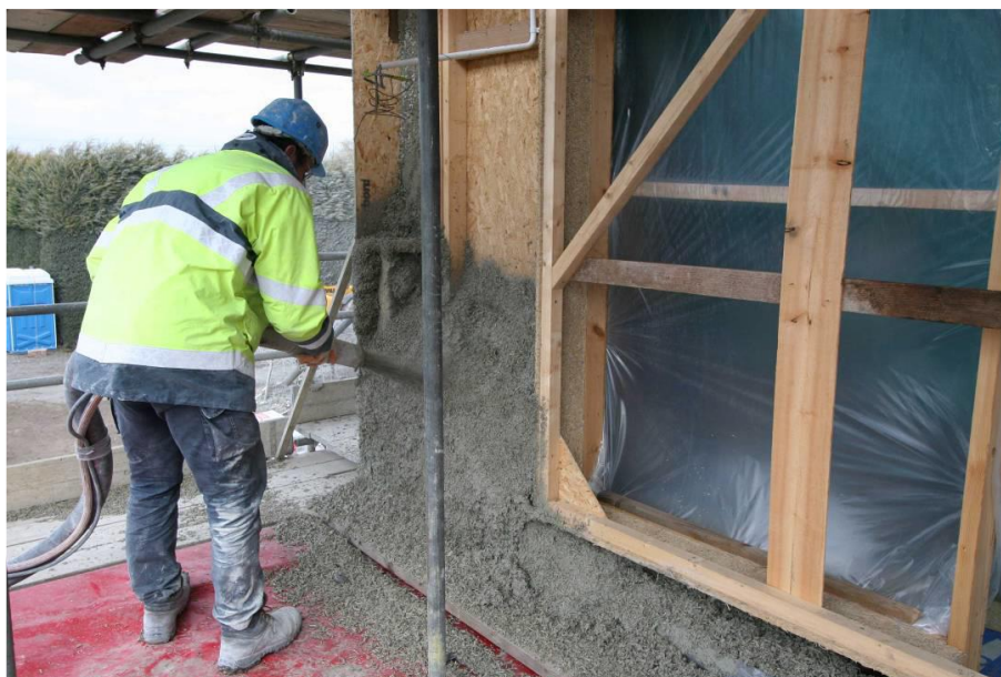
Obr. 35: Aplikace konopného betonu nástřikem (Lupu, 2022)
