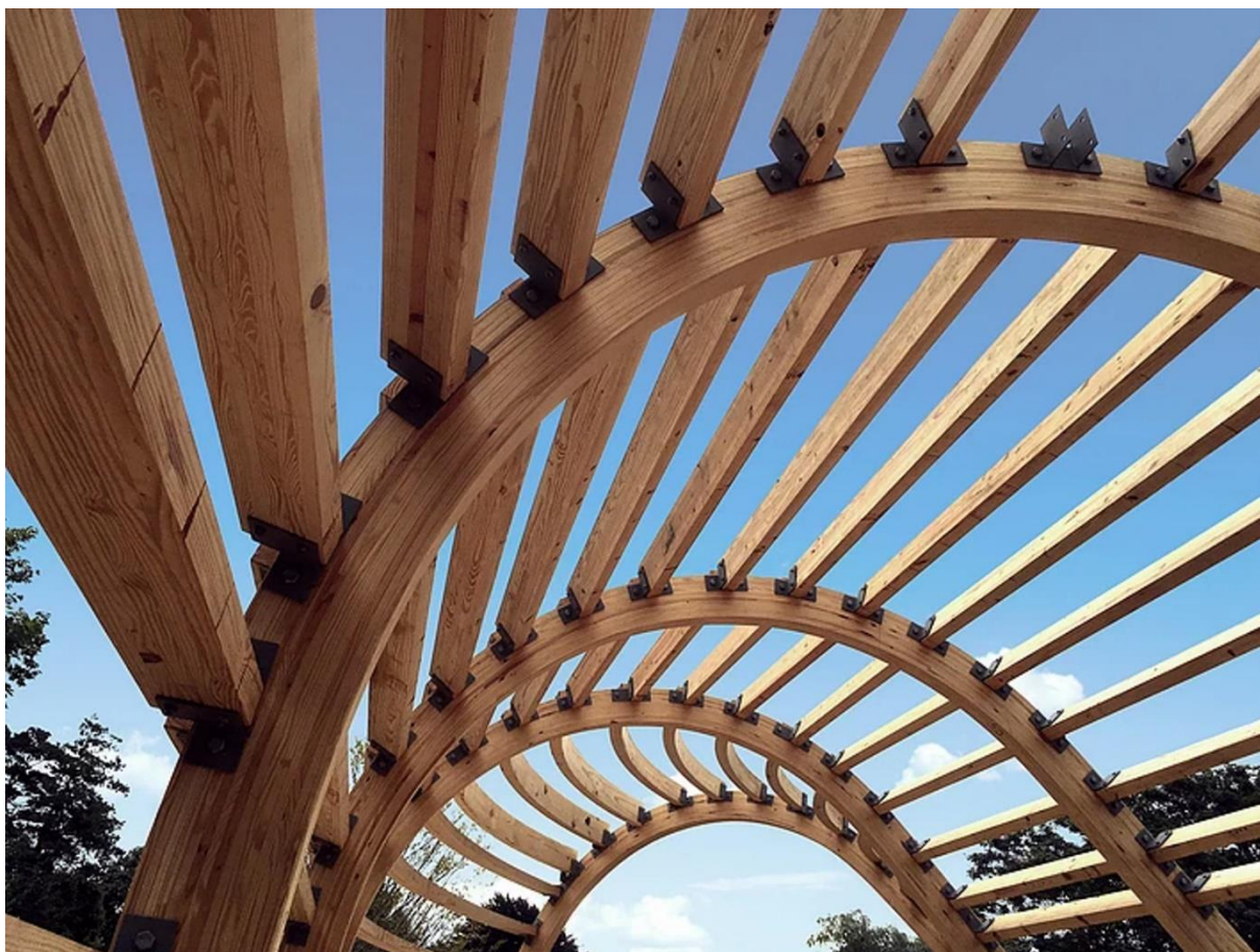
Obr. 5: Ukázka použití lepeného lamelového dřeva pro tvarované konstrukce (BeautexWood, 2020)
