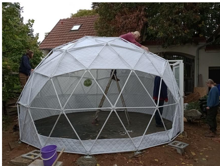
Obr. 31: Montáž stanu geodetické kopule (vlastní fotografie)
