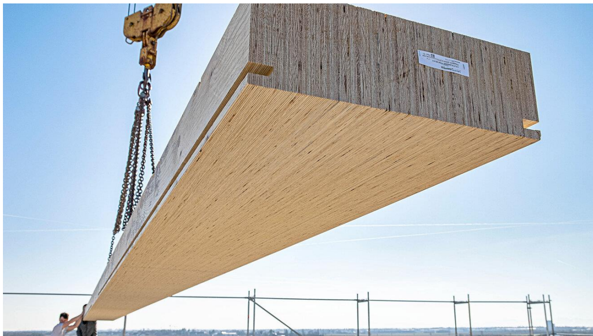
Obr. 7: Manipulace LVL prvku na staveništi (STEICO, 2023)
