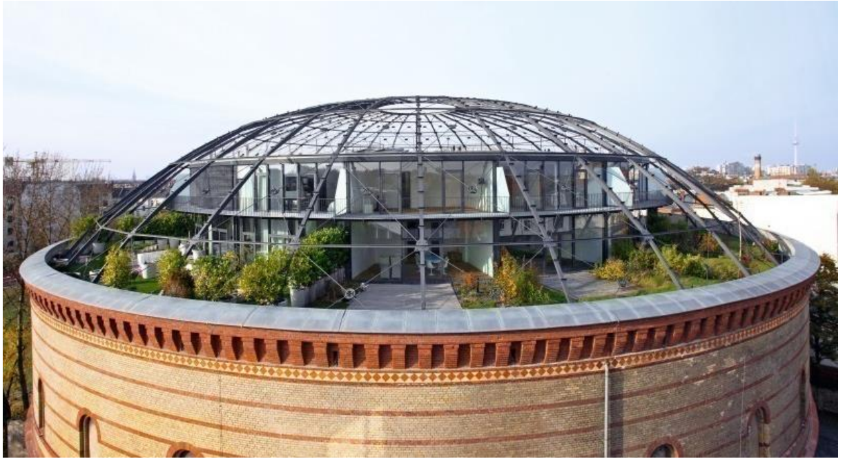
Obr. 25: Schwedlerova kopule na střeše plynárny – Fichtebunker, Berlin (Macdonald, 2017)
