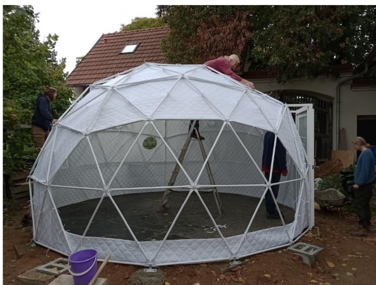
Obr. 31: Montáž stanu geodetické kopule (vlastní fotografie)
