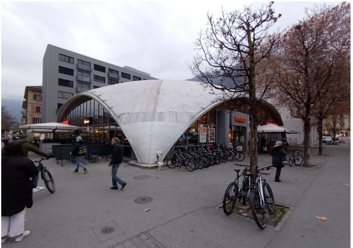
Obr. 33: Železobetonová kopule – Bellinzona Švýcarsko (vlastní fotografie)
