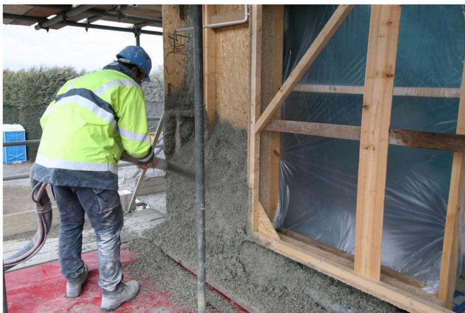
Obr. 35: Aplikace konopného betonu nástřikem (Lupu, 2022)
